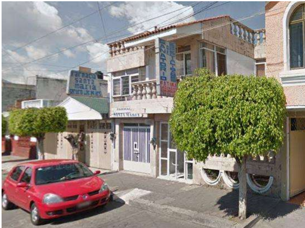
Fig. 07, Clínica de Especialidades "Fátima", Fachada Principal, Fuente Google Maps
