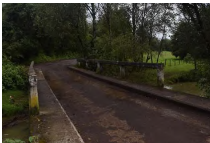
Ilustración 45. Puente que va para el Asoleadero, Laguna Verde y Los Fresnos. Fotografía tomada por Citlalin Marina Reséndiz Sánchez, 14 de octubre del 2017.
