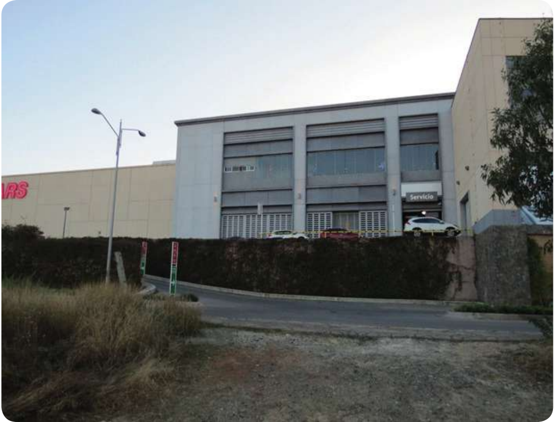
IMAGEN 50. Vista desde el interior del terreno hacia Sears y la agencia de autos Honda. FUENTE: Fotografía tomada por la autora
