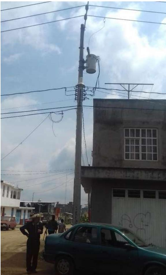
Fig. 58 Poste de luz con transformador, elaboración propia octubre del 2018.
