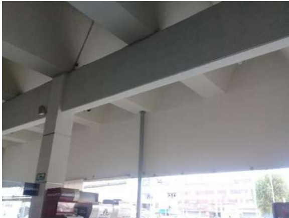
ESTRUCTURA DE LA CENTRAL DE IRAPUATO GUANAJUATO, INTERIOR
