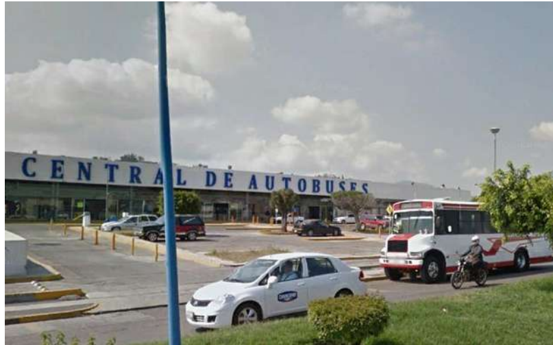
FOTOGRAFIA NO. 38 NOMBRE: ACCESOS PEATONALES Y ESTACIONAMIENTO DE LA CENTRAL DE AUTOBUSES DE LA PIEDAD MICH. FUENTE: JOSÉ GUADALUPE OCHOA EQUIHUA[23-09-2017].
