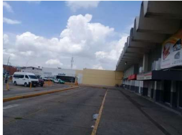
ESTRUCTURA DE LA CENTRAL DE IRAPUATO GUANAJUATO, EXTERIOR
