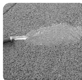
Ilustración 86 Piso de Concreto permeable
