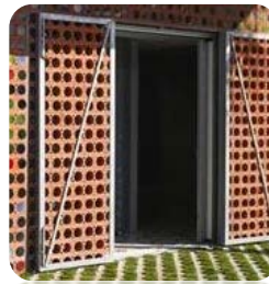
Ilustración 81 Puerta de Celosía con estructura metálica
