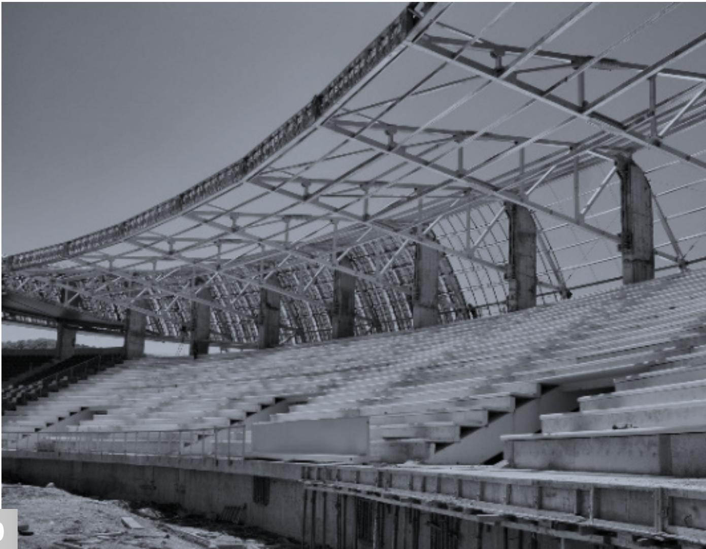
Como podemos ver en la imagen se tomará el mismo sistema constructivo, materiales para las gradas como el concreto, son unidades prefabricadas colocadas sobre columnas inclinadas soportadas por pilares a cada 10mts de separación.
