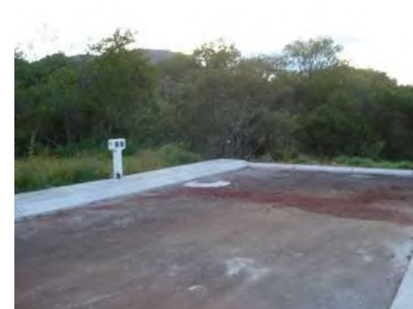
Predio, Infraestructura (pavimentación)
