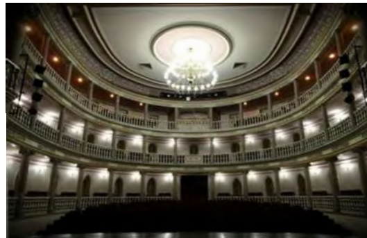
T. Morelos, estado actual, vista hacia palcos
