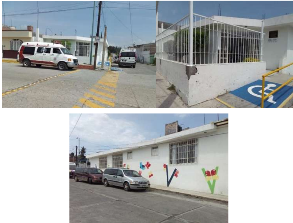
Figura 3. Unidad Básica de Rehabilitación Álvaro Obregón. A) fachada principal. B) acceso principal. C) fachada lateral derecha.
