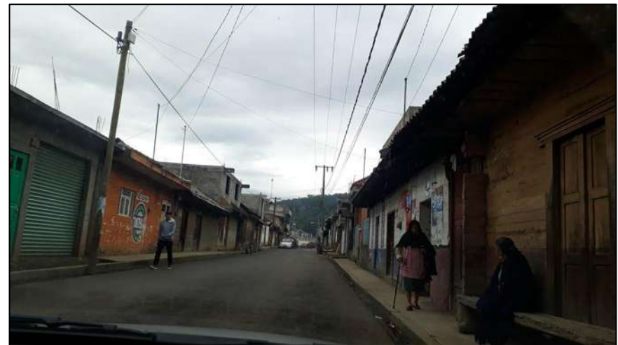
Figure 19 ACTUAL VIVIENDA EN EL CENTRO DE LA LOCALIDAD, CRÉDITOS: FUENTE PROPIA, AGOSTO 2019
