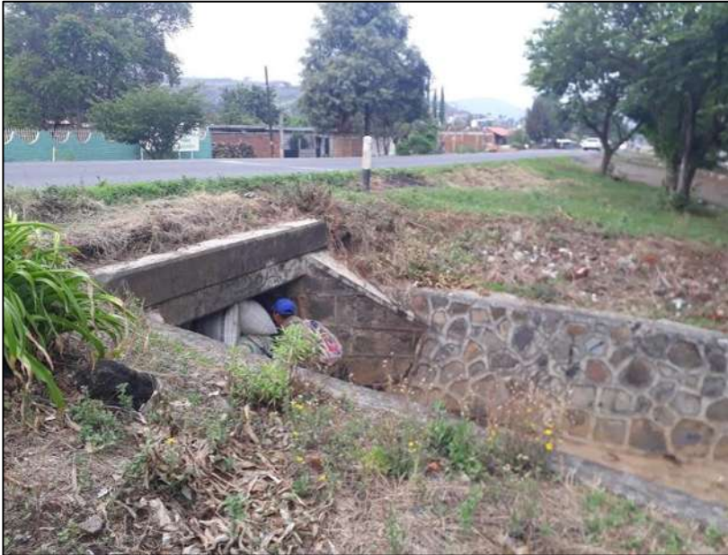
Figure 33 DUCTO DE DESAGÜE, FUENTE PROPIA, AGOSTO 2019
