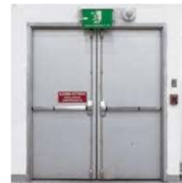
Fig. N° 129 Salida de emergencia
