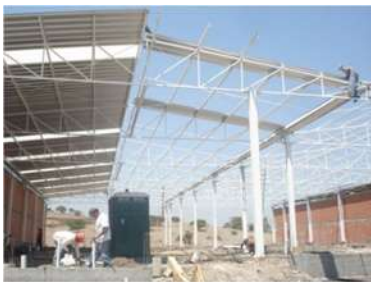
Fig. N° 127 Armadura tipo PRATT
