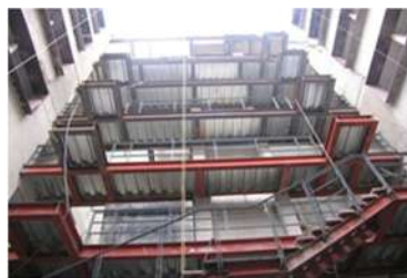
Fig. N° 131 Losacero en escaleras
