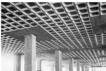
Fig. N° 130 Losa reticular
