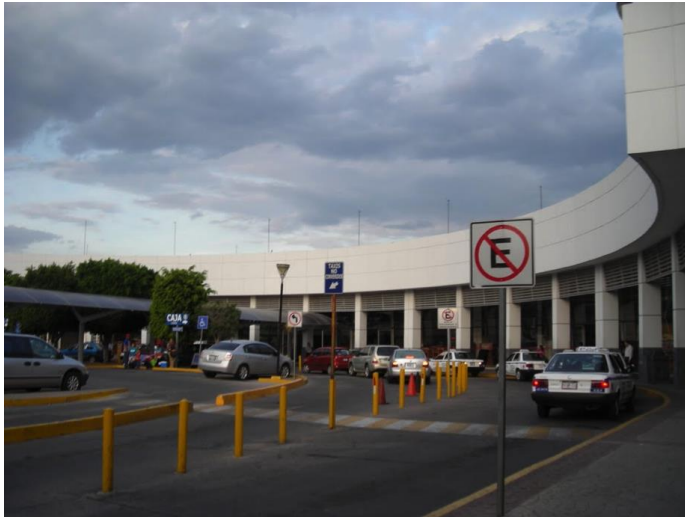
Imagen 26. Fachada de la Terminal de León de los Almada
