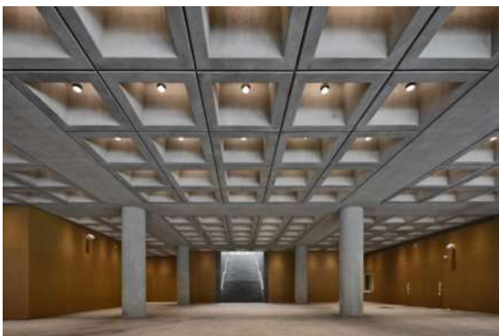
Imagen 53. Losa reticular aparente. Fotografía tomada de la pág. https://www.arqhys.com/articulos/losas-nervadas-reticulares . Diciembre del 2017
