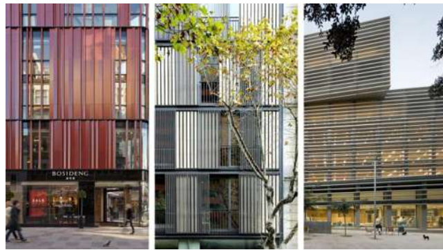
Imagen 39. Ejemplos de protección solar en fachadas. Fotografía tomada de la pág. https://www.archdaily.mx/mx/02-341756/edificios-proteccion-solar-en-fachadas . Diciembre del 2017
