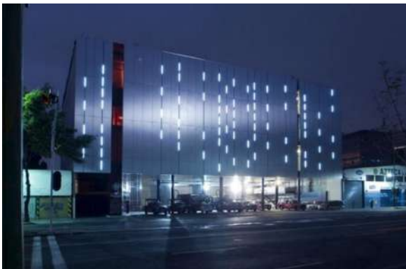
Imagen 7. Fachada de la estación de bomberos Ave Fénix de la CDMX tomada de la página https://www.archdaily.mx/mx/02-27731/estacion-de-bomberos-ave-fenix-at-103-plus-bgp-arquitectura . Noviembre del 2017
