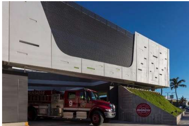
Imagen 14. Vista perspectiva de la estación de bomberos Boca del río tomada de la página https://www.archdaily.mx/mx/885257/estacion-de-bomberos-boca-taller-diez-05 . Noviembre del 2017
