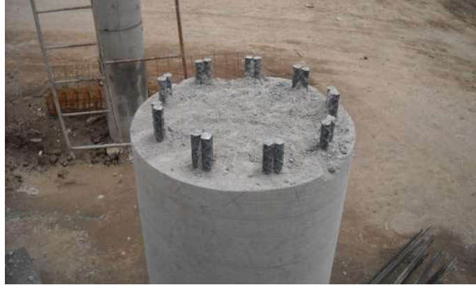
Imagen 56. Columna de concreto armado. Fotografía tomada de la pág. https://www.arqhys.com/construction/columnasconcreto . Diciembre del 2017
