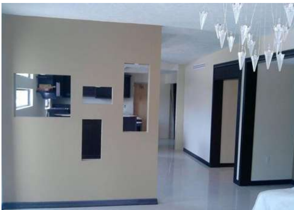
Imagen 92. Muro de tabla roca.
