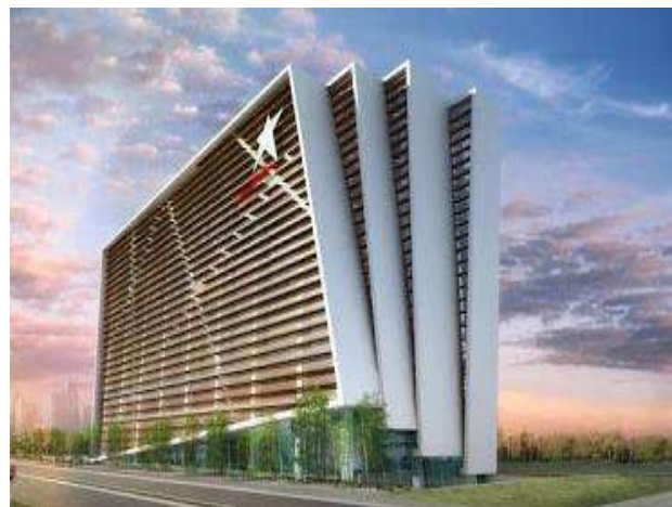
Imagen 60. Sede de televisión en china Fuente: http://www.ibimi.it/grandi-opere-e-bim-il-quartier-generale-cctv-pechino/ . 12 de Septiembre 2018.
