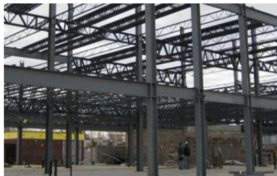
Imagen 88. Sistema constructivo a base de columnas metálicas
