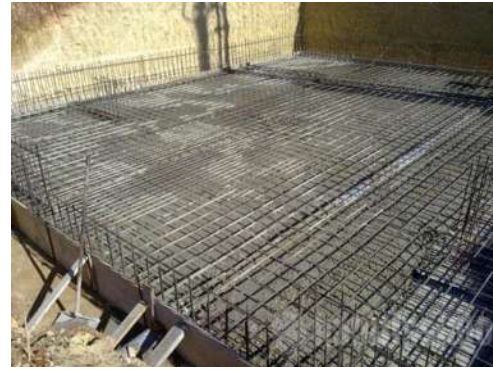
Imagen 87. Losa de cimentación. Fuente:
