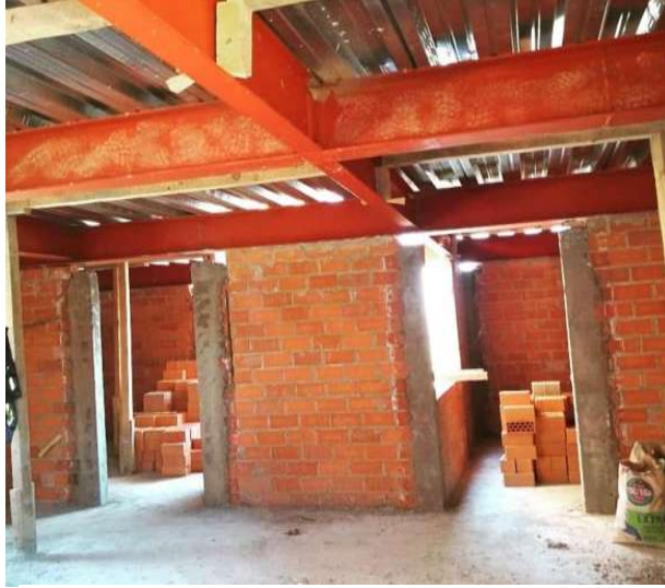
Imagen 90. Muro de tabique .
