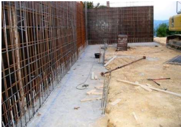
imagen 91. muro de contención
