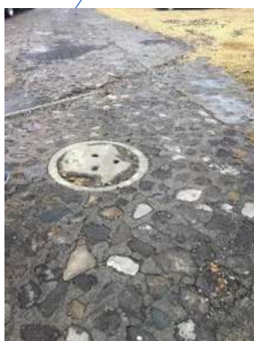
Imagen 18.-Coladera Registro Principal. Fotografía del terreno tomada por NPRA
