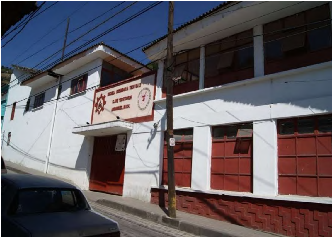
Ilustración 37 Escuela Secundaria Técnica No. 2 Angangueo Fuente: (Hernández Aceves, 2019)
