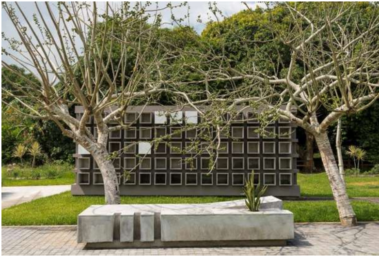
Ilustración 16 Muro exterior de gavetas
