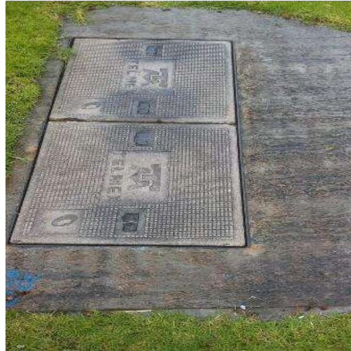
Ilustración 54 Líneas de teléfono
