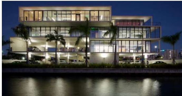
Ilustración 9 Fachada. Fuente: http://arqa.com/arquitectura/sede-de-glf.html
