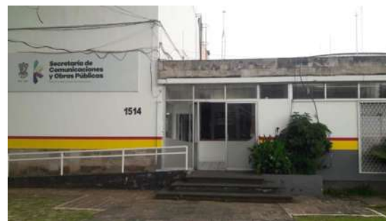
Ilustración 6 Fachada Norte. Fuente: autor, agosto 2018
