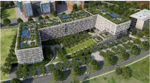
Ilustración 46. Edificio Flavors Orchard, ejemplo de arquitectura sustentable en China. Foto tomada en https://blog.is-arquitectura.es/2014/02/25/flavors-orchard-distrito-sostenible-para-kunming-china/
