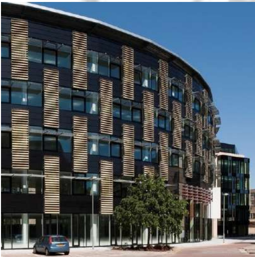
Ilustración 59. Fachada de una edificación en Nueva York. Foto tomada de Google imágenes.
