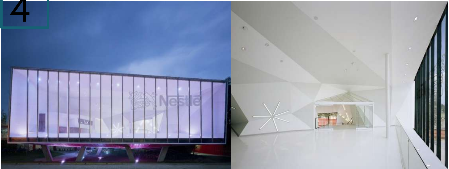
Ilustración 11. Lobby vista Exterior e Interior.
