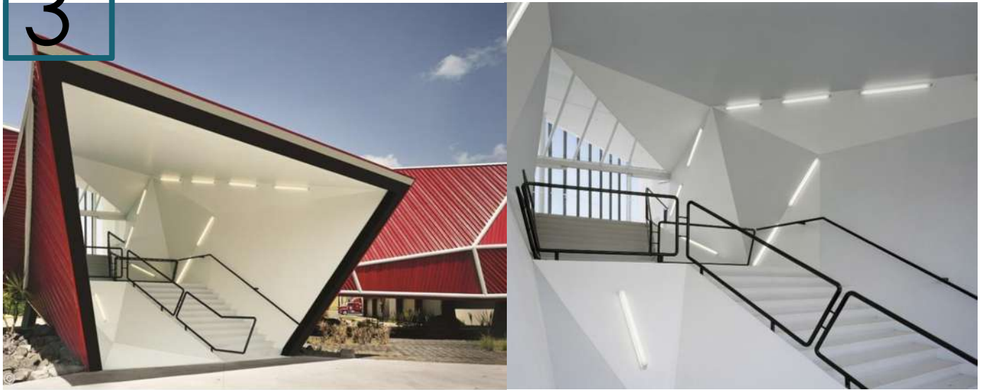
Ilustración 10. Acceso a Museo vista Exterior e Interior.
