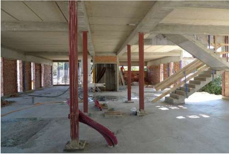
Figura 57 Interior de Obra negra CPHS. Fuente: Ayuntamiento de Pamplona
