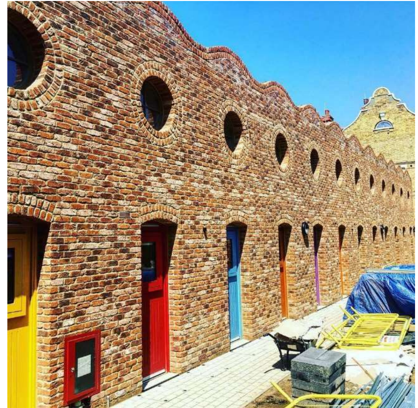
Figura 13 Vellore House. Fuente: Archello
