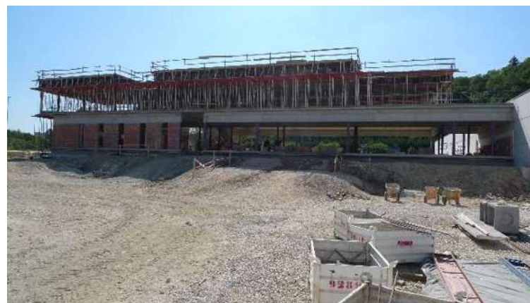
Figura 56 Obra negra CPSH. Fuente: Ayuntamiento de Pamplona
