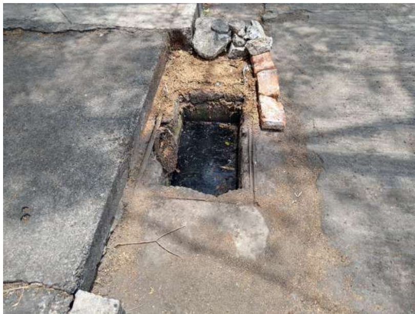
Imagen 50 vista de las condiciones actuales de las colindancia del terreno, Autoría propia, Juan Carlos Lazcano Martínez
