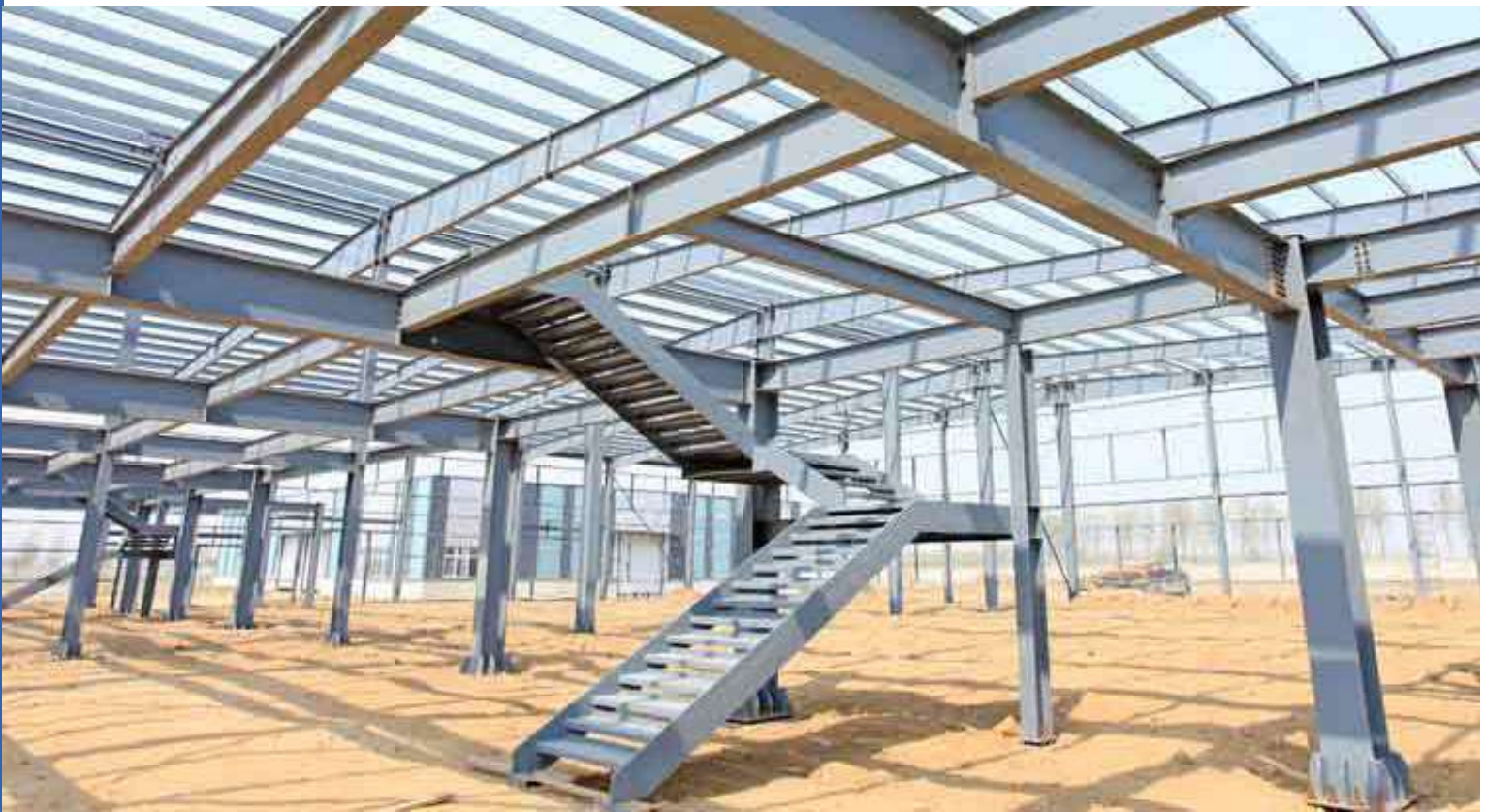
Imagen 83 Construcción de estructura de acero, https://blog.laminasyaceros.com/blog/topic/construcci%C3%B3n
