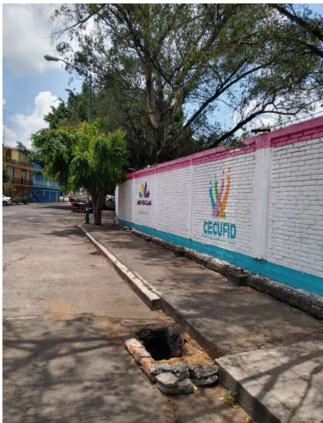
Imagen 49 vista de las condiciones actuales de las colindancia del terreno, Autoría propia, Juan Carlos Lazcano Martínez
