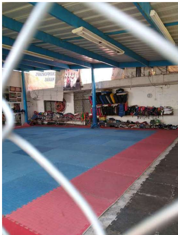
Imagen 63 Condiciones Antigua Instalación , Autoría propia, Juan Carlos Lazcano Martínez
