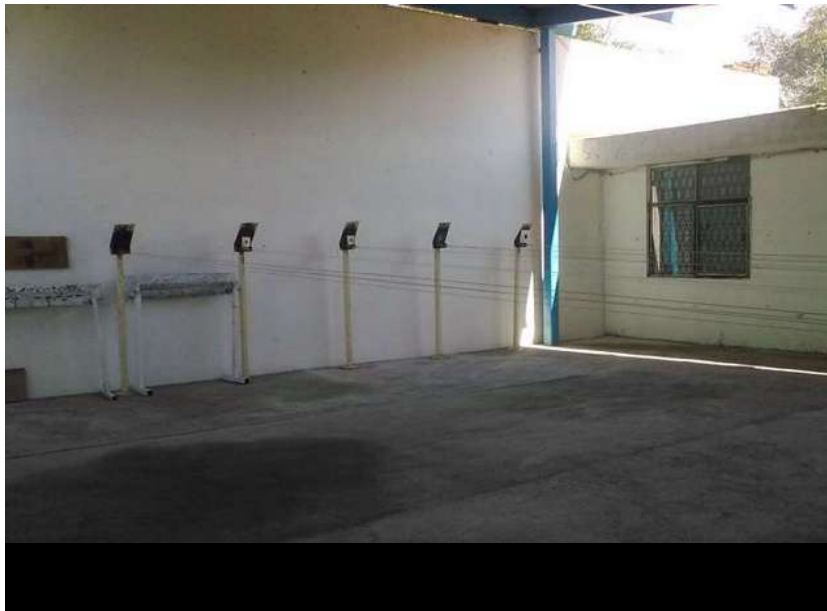
Imagen 58 vista de las condiciones anteriores de las instalaciones, Autoría propia, Juan Carlos Lazcano Martínez
