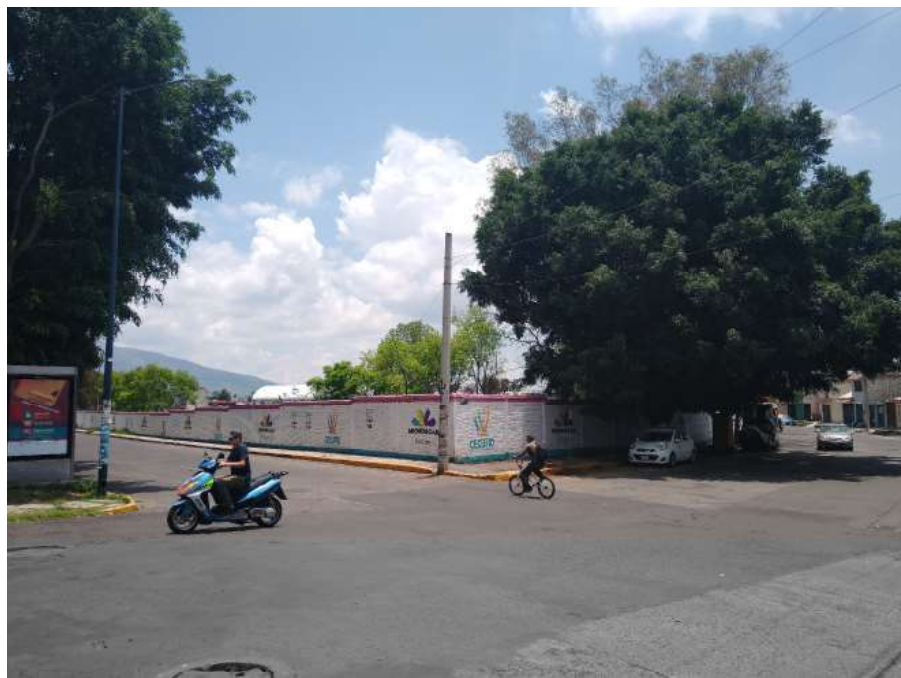
Imagen 51 vista de las condiciones actuales de las colindancia del terreno, Autoría propia, Juan Carlos Lazcano Martínez
