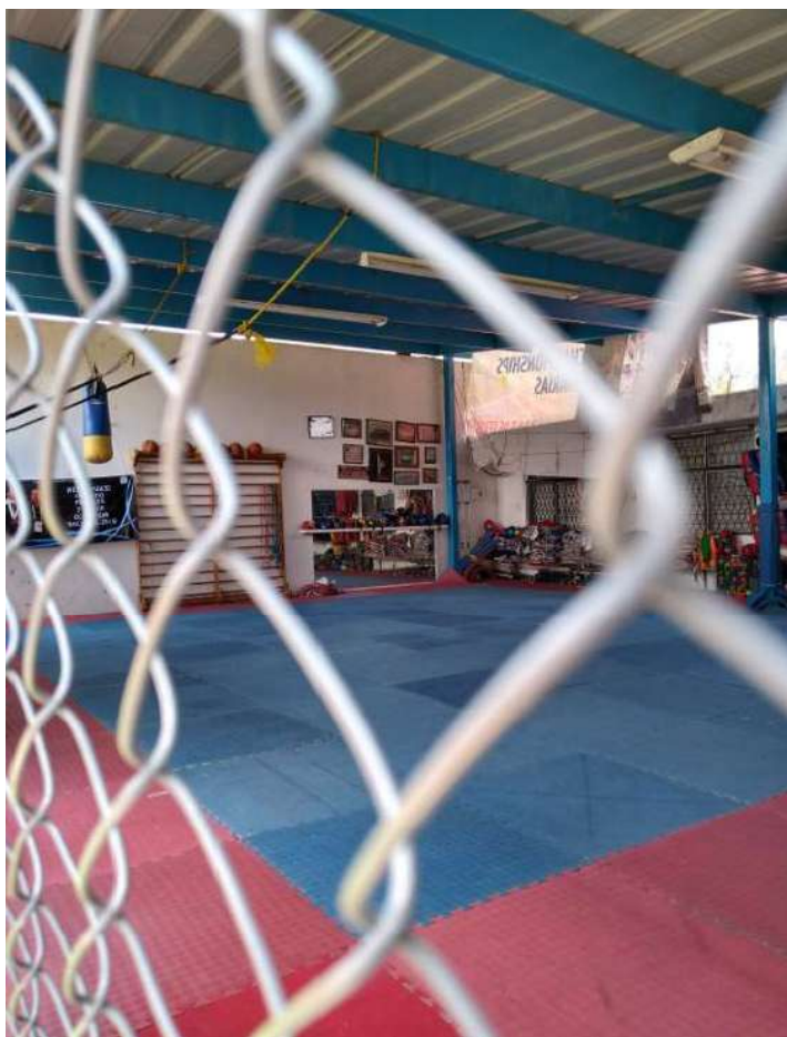
Imagen 64 Condiciones Antigua Instalación , Autoría propia, Juan Carlos Lazcano Martínez
