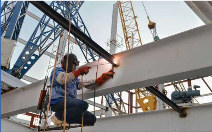
Imagen 82 Construcción de estructura de acero, https://blog.laminasyaceros.com/blog/topic/construcci%C3%B3n
