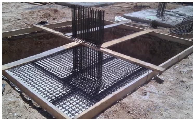
Ilustración 137. Imagen ilustrativa del armado de una zapata aislada. Fuente: <https://www.elblogdeapa.com/wp-content/uploads/2015/08/zapata-aislada-02.png>. Ago/2019
