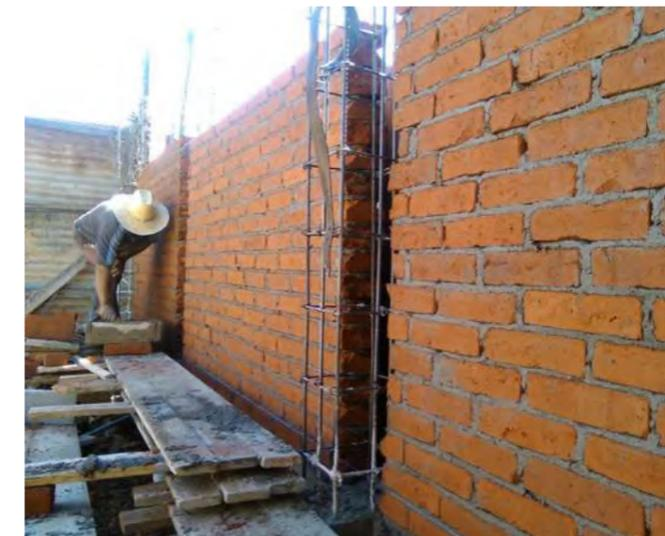
Ilustración 152. Imagen ilustrativa de un muro de tabique rojo recocido Fuente: <https://i.pinimg.com/originals/71/b0/d9/71b0d9dc-482ba7b768c2ddb33046b58f.jpg>. Ago/2019
