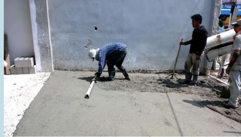
Ilustración 151. Imagen ilustrativa de la elaboración de un firme de concreto Fuente: <https://i.ytimg.com/vi/etW8a2ub-Nw/maxresdefault.jpg>. Ago/2019
