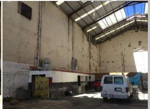
Fotografía 3, Interior del inmueble Cine Odeón, tomada por autor, diciembre 2018
