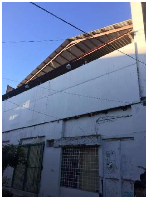
Fotografía 13, Exterior del inmueble Cine Odeón, tomada por autor, diciembre 2018
