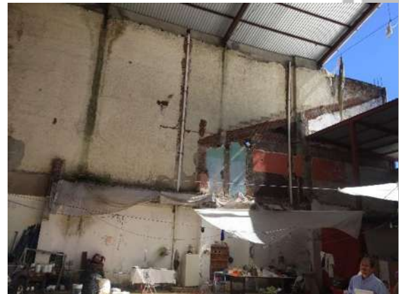
Imagen 2, Estado actual del interior del antiguo cine Odeón, Fotografía tomada por Rommel Rodríguez Calderón, noviembre 2018
