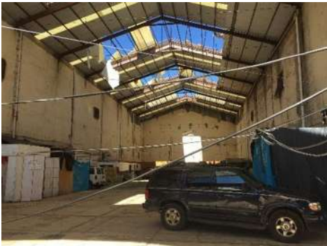
Fotografía 1, Interior del inmueble Cine Odeón, tomada por autor, diciembre 2018
