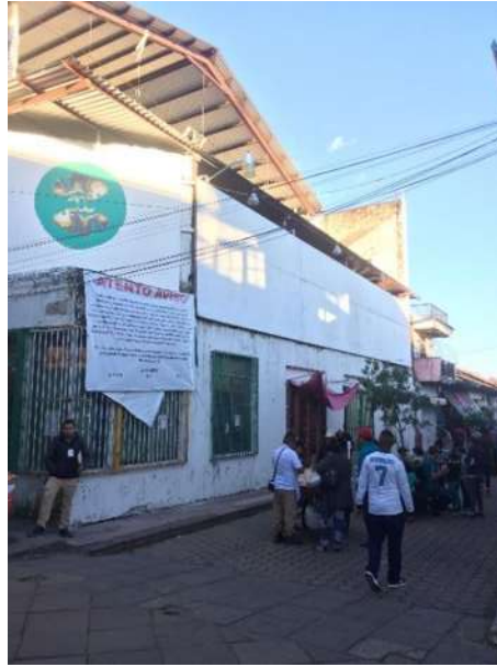
Fotografía 11, Exterior del inmueble Cine Odeón, tomada por autor, diciembre 2018
