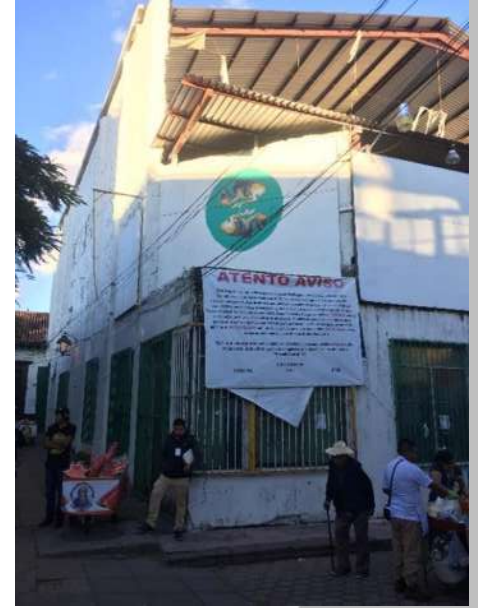
Fotografía 12, Exterior del inmueble Cine Odeón, tomada por autor, diciembre 2018
