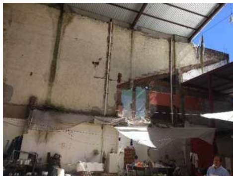
Fotografía 5, Interior del inmueble Cine Odeón, tomada por autor, diciembre 2018
