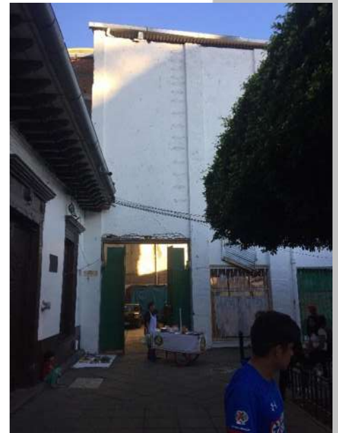
Fotografía 14, Exterior del inmueble Cine Odeón, tomada por autor, diciembre 2018
