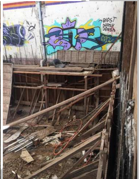
Fotografía 9, Interior del inmueble Cine Odeón, tomada por autor, diciembre 2018
