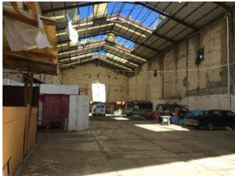
Fotografía 2, Interior del inmueble Cine Odeón, tomada por autor, diciembre 2018
