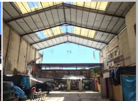
Fotografía 6, Interior del inmueble Cine Odeón, tomada por autor, diciembre 2018
