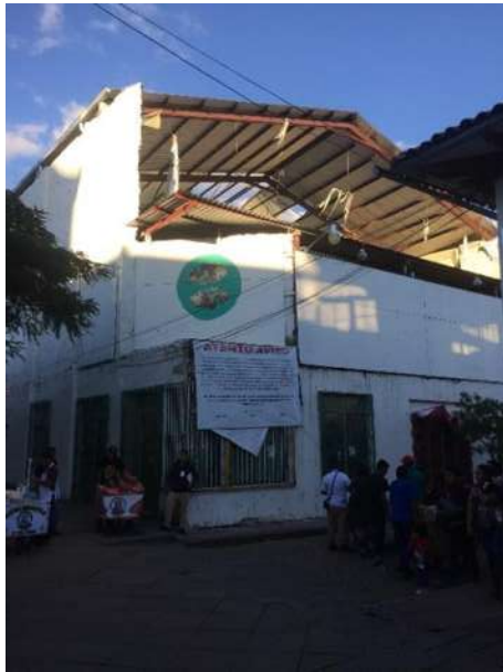
Fotografía 10, Exterior del inmueble Cine Odeón, tomada por autor, diciembre 2018
