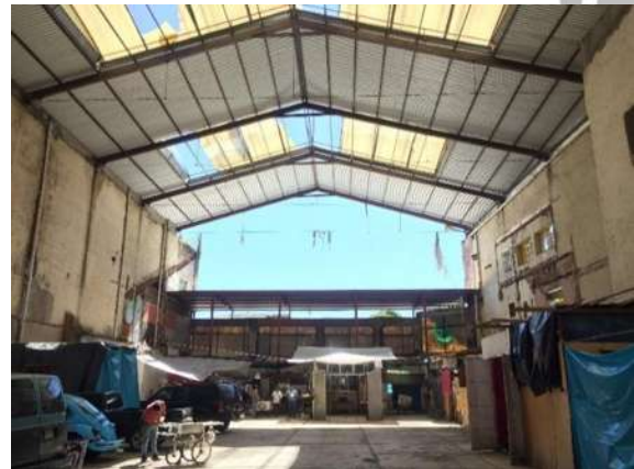
Imagen 1, Estado actual del interior del antiguo cine Odeón, Fotografía tomada por Rommel Rodríguez Calderón, noviembre 2018
