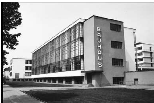
FIG.6 Fotografía de la Bauhaus, Autor archdaily.2018
