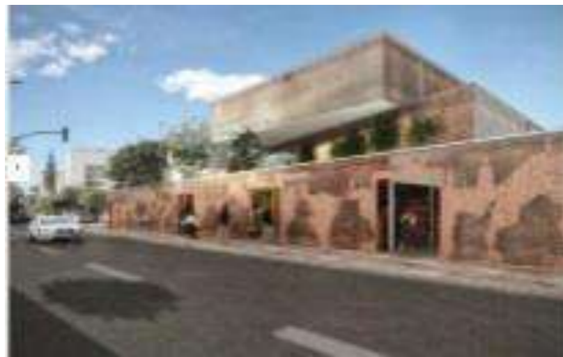
Ilustración 1.- Vista principal de la Plaza
