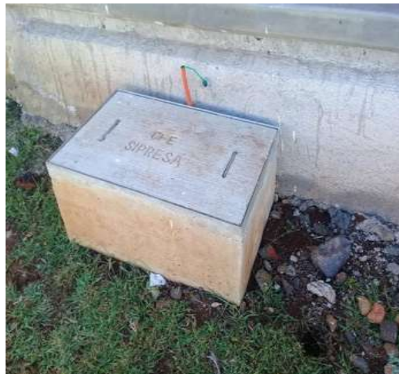
Ilustración 26: Registro de CFE fuente: RAV [06/11/18]
