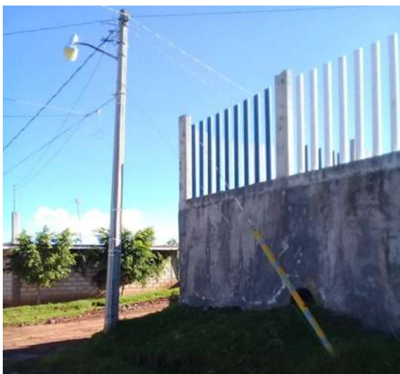
Ilustración 25: poste de alumbrado público fuente: RAV [01/11/18]
