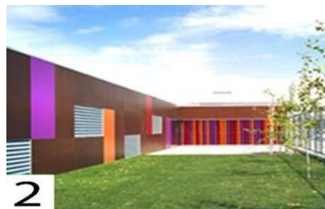
Ilustración 7. Centro de Educación Infantil "Rosales del Canal" / Magén Arquitectos,
