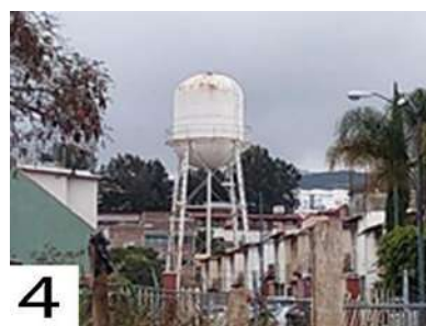
Ilustración 35. Tanque de agua en la zona, Fuente: R.H.M.A
