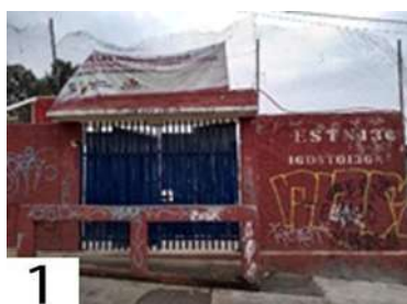
Ilustración 31. Fachada de escuela, fuente: R.H.M.A
