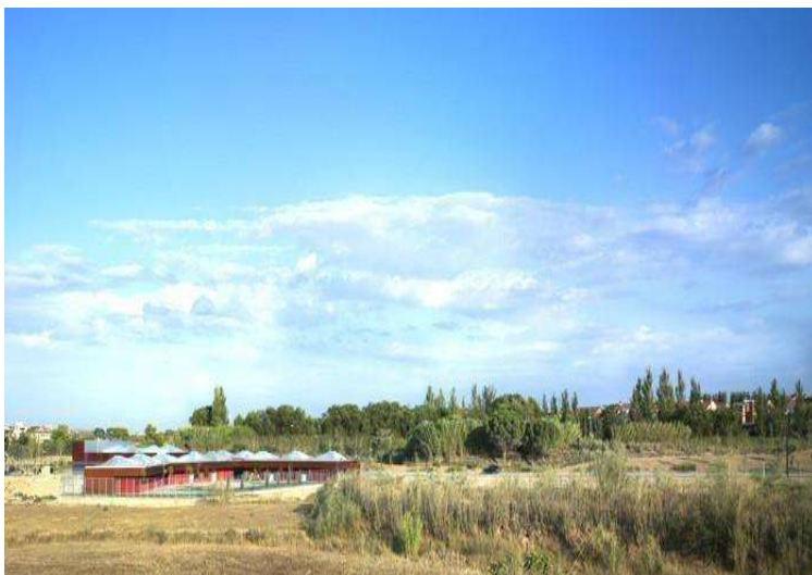
Ilustración 11. Centro de Educación Infantil "Rosales del Canal" / Magén Arquitectos, disponible en: https://www.archdaily.mx/mx/02-40343/centro-de-educacion-infantil-rosales-del-canal-magen-arquitectos
