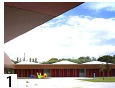
Ilustración 6. Centro de Educación Infantil "Rosales del Canal" / Magén Arquitectos,
