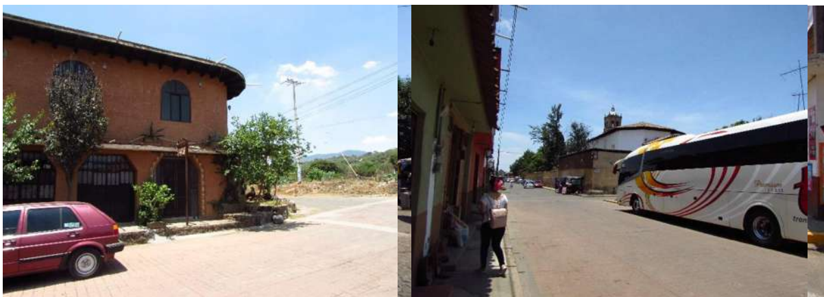
Vista de calle av. Vasco de Quiroga. Esquina con calle Juan Bautista Moya de material adoquín. En la segunda imagen apreciamos la calle av. Vasco de Quiroga, pero a la altura de la calle Mariano Matamoros de material adoquín.
