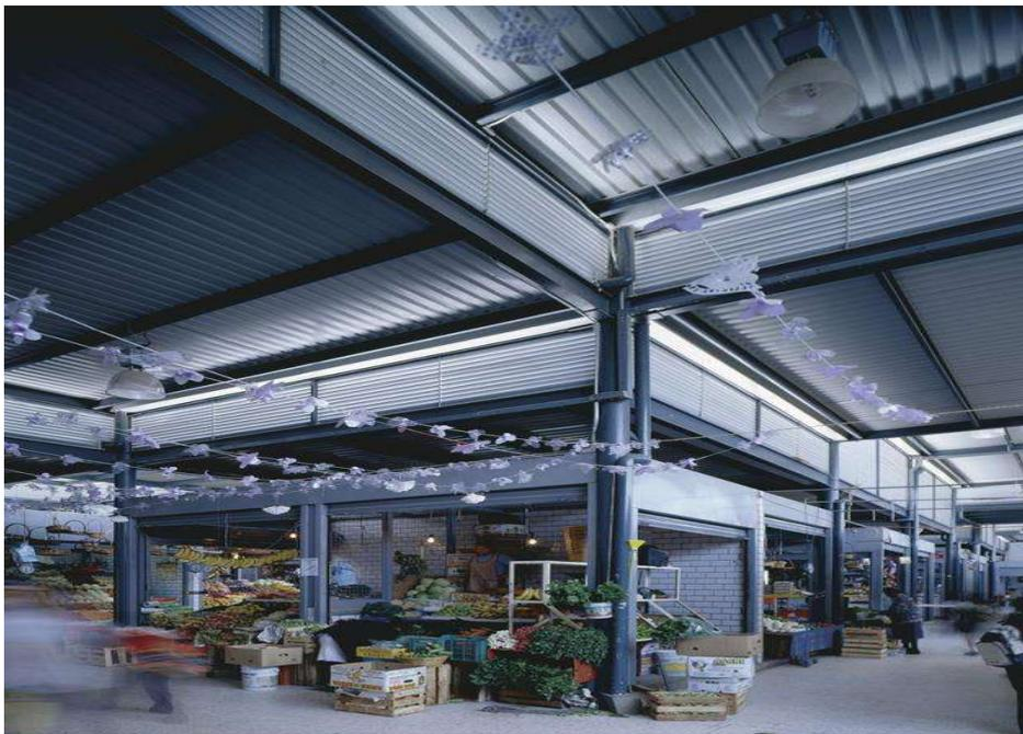
Fig. 5 – se puede observar las diferentes alturas de las cubiertas y además el acceso de luz natural al edificio.
