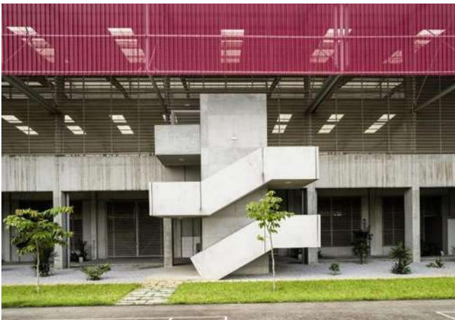
Ilustración 12. Fachada principal. Recuperado de: https://www.archdaily.mx/mx/921702/gimnasio-de-la-escuela-secundaria-blaise-pascal-koffi-and-diabate-architectes . [Fecha de consulta: junio 2018].
