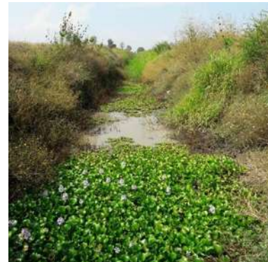
F08 Canal de riego 2
