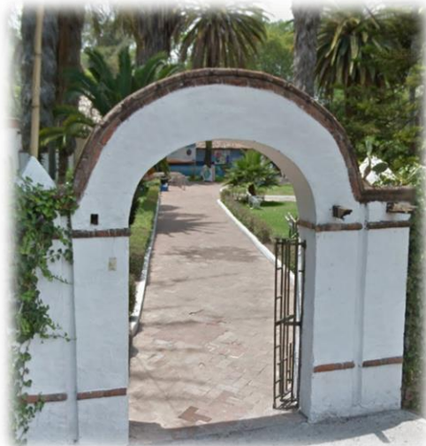
Ilustración 45 Acceso oeste, fuente Google maps.
