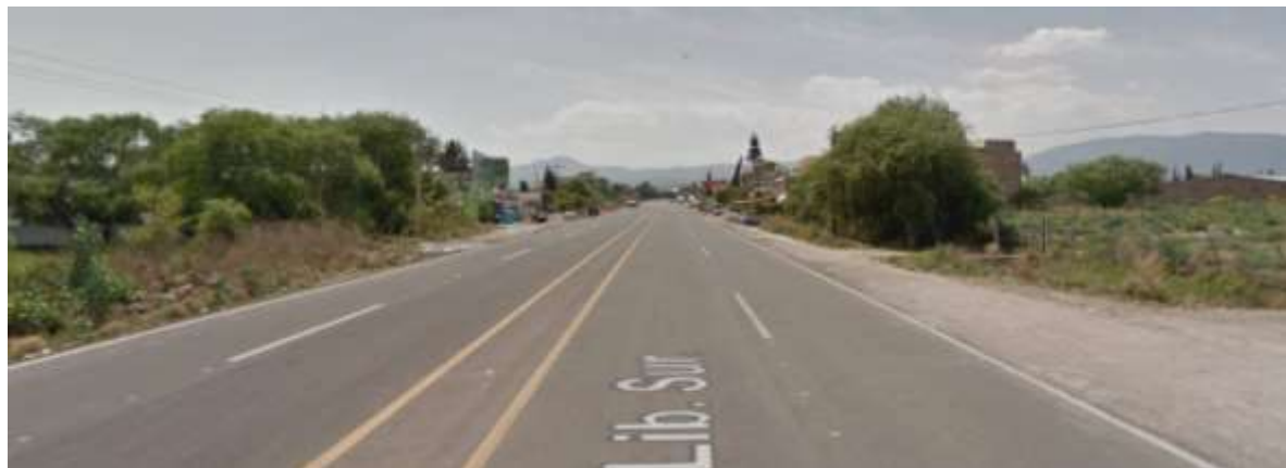
Imagen 30 Libramiento Sur, fotografía frente al terreno, (octubre 18), Google Maps.
