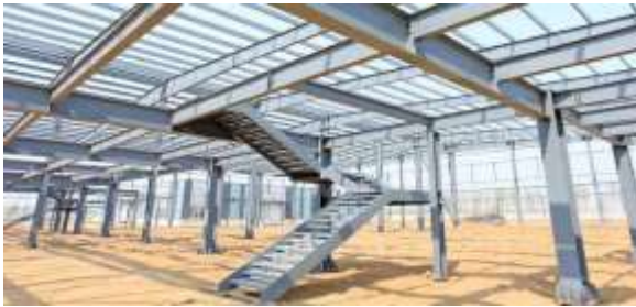
Imagen 50 Ejemplo de estructura metálica a base de perfiles IPR, (agosto 2019), Recuperado de: http://arcosytechos.com/site/diapositiva3/
