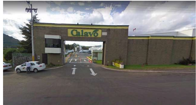
Imagen 20 fachada de la planta procesadora y empacadora de aguacate el "CALAVO" fuente google earth.
