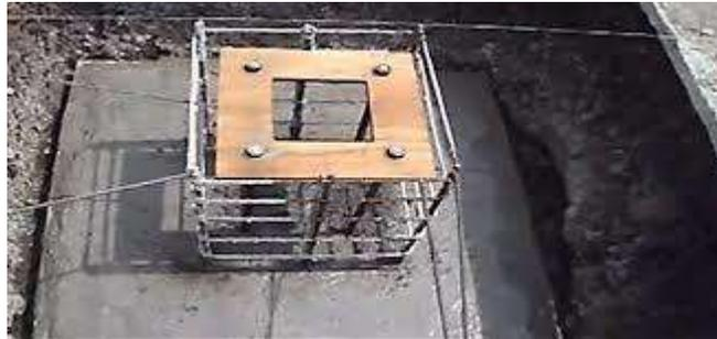
*Imagen 38: Zapata para recibir Columna de Acero. Fuente: [http://aducarte.weebly.com/uploads/5/1/2/7/5127290/22\\_columnas.pdf](http://aducarte.weebly.com/uploads/5/1/2/7/5127290/22_columnas.pdf)*
