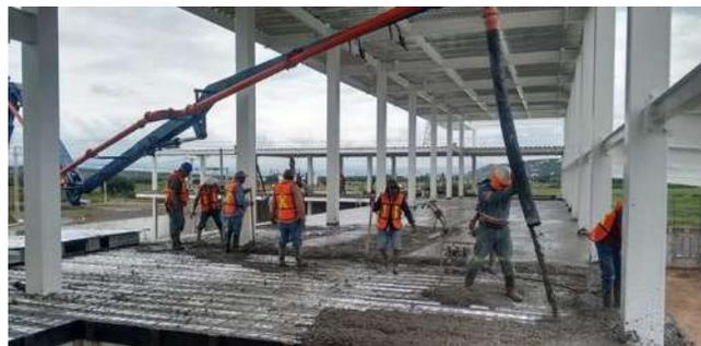
*Imagen 40: Losacero. Fuente: <https://arqzon.com/2018/11/08/sistema-losacero/>*
