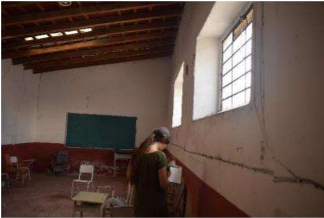
Fig. 30, Levantamiento arquitectónico, se miden las alturas de vanos de ventanas, Autor: López Nava Fco. Javier [enero 2019]
