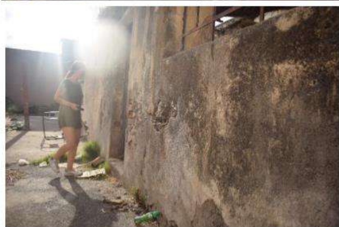
Fig. 32, Levantamiento arquitectónico, se miden las alturas distancias de aulas, Autor: López Nava Fco. Javier [enero 2019]
