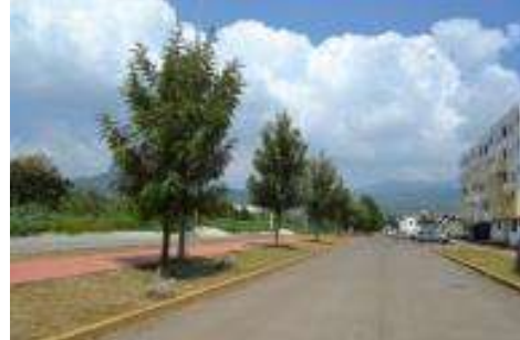
Figura 24 Calles pavimentadas Fuente. Generada por la autora
