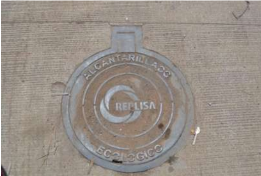
Figura 47. Infraestructura, alcantarillado. Fuente. Generada por la autora
