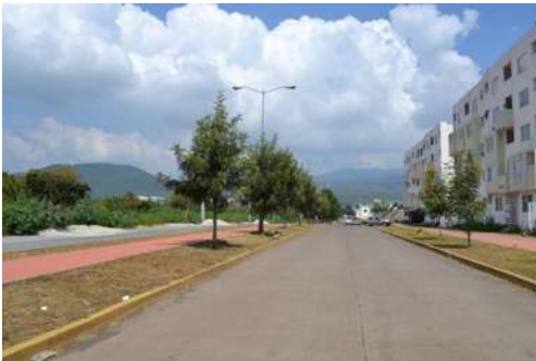
Figura 49. Infraestructura, pavimentación. Fuente. Generada por la autora.
