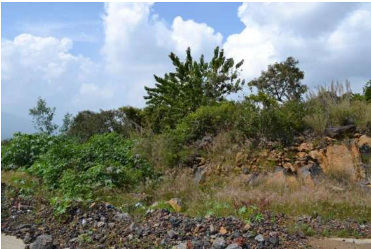
Figura 6. Afectaciones en el terreno. Fuente. Generada por la autora
