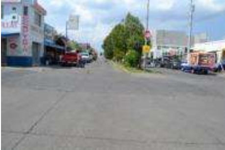
Figura 23 Calles pavimentadas Fuente. Generada por la autora
