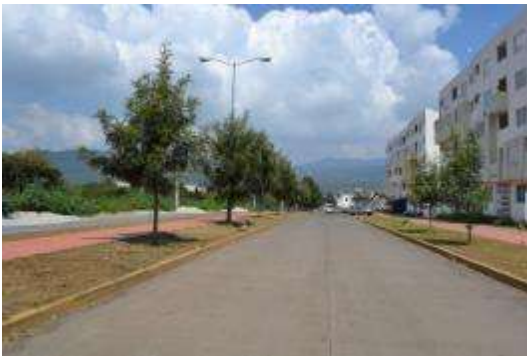
Figura 20. Alumbrado público en las calles. Fuente. Generada por la autora
