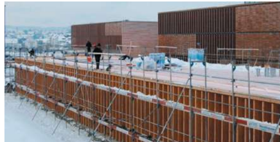
Imagen 43: Construcción de la cafetería. (2018)
