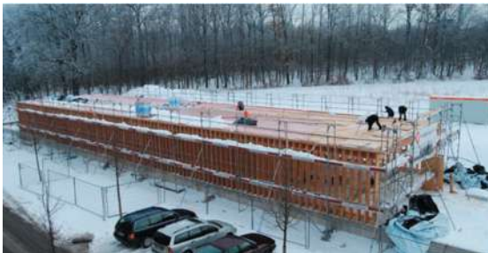
Imagen 42: Construcción de la cafetería. (2018)
