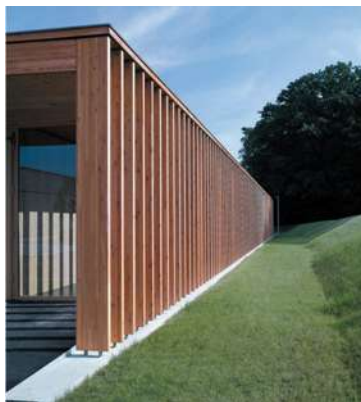
Imagen 35: Pilares de maderas de la estructura. (2018)
