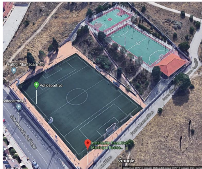
Fig.26. Instalaciones de la unidad AUTOR: SAVB 10/11/2018
