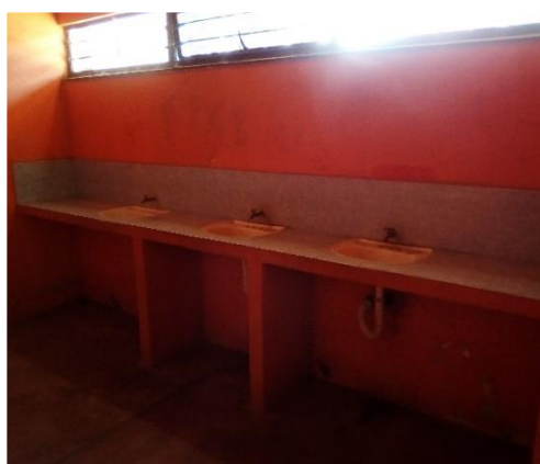
Fig. 72. Sanitarios, lavamanos Autor: SAVB 23/09/18
