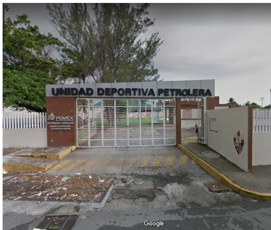
Fig.19. Acceso a la unidad deportiva “petrolera”
