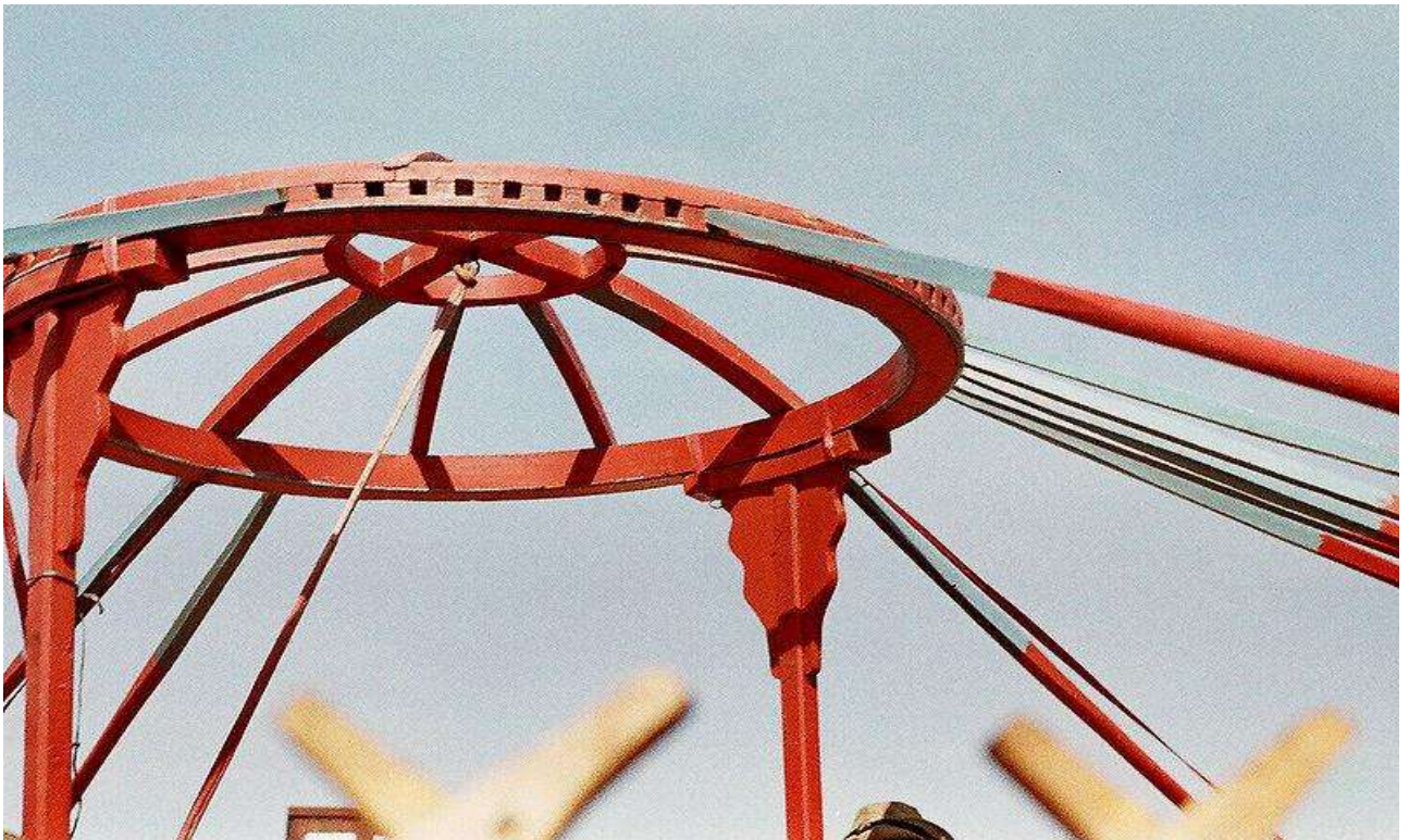
IMAGEN 118. Anillo de techo
