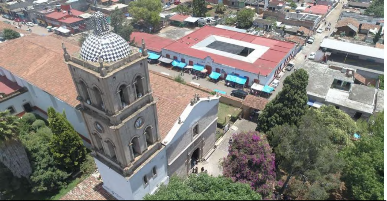
IMAGEN 79. Fachada sur-este FUENTE: propio FECHA DE CONSULTA: 8 de octubre del 2018.
