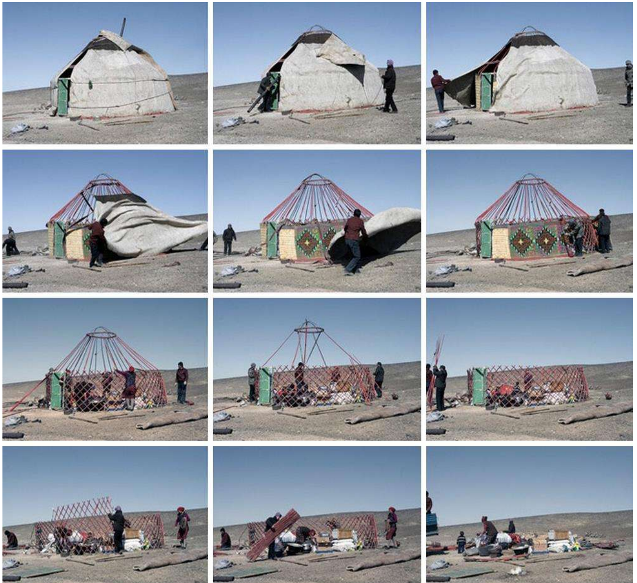
IMAGEN 117. Construcción de la Yurta
