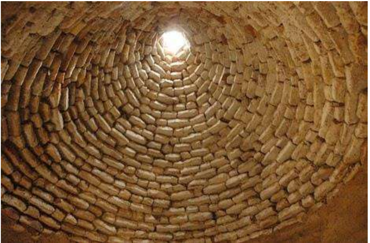
IMAGEN 113. Interior de la vivienda colmena, Turquía
