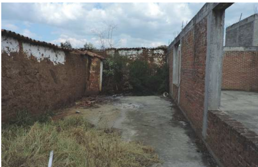
Figura 39. Patio trasero vista a colindancia
