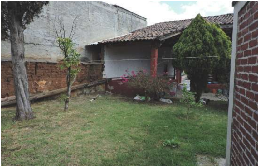
Figura 35. Portal visto desde patio central
