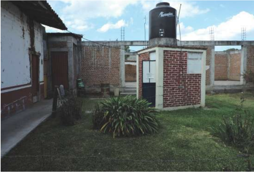
Figura 34. Patio central visto desde pórtico
