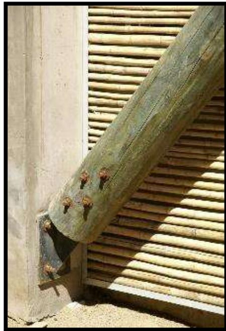
**Fig. 1.28.** Detalle de la diagonal de madera que funciona como arriostrador
