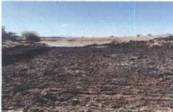
EN CORTES DE OBRA
