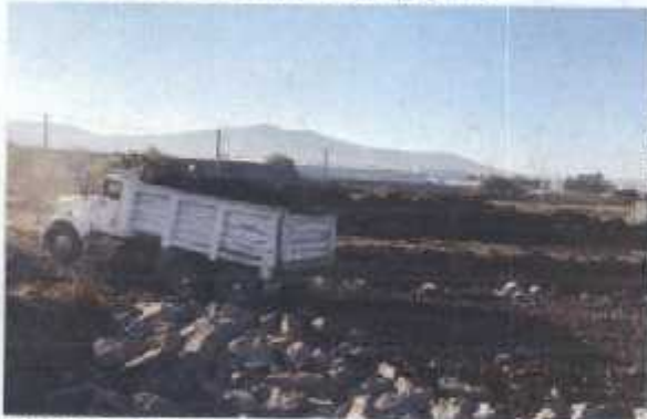
CAPA DE FILTRO EN OBRA
