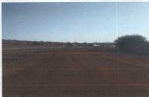
CAPA DE SUB BASE EN TAPONAMIENTO EN OBRA
