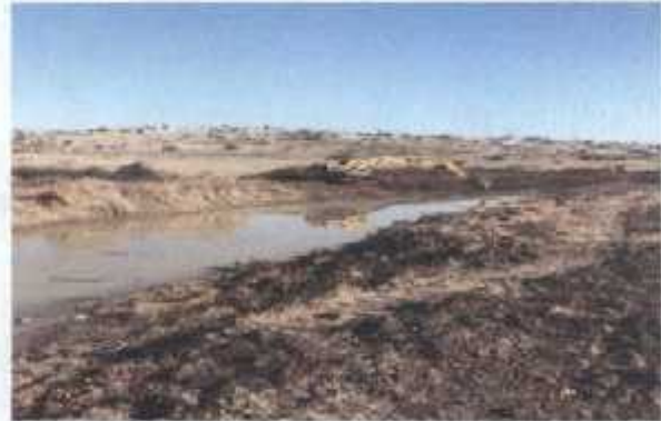
DESPALME DE OBRA
