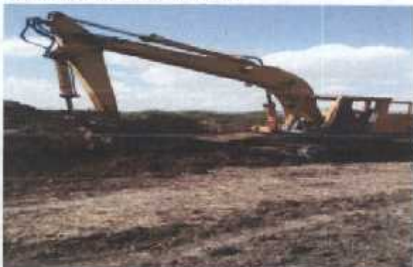
EXCAVACION DE CEPAS PARA M.C
