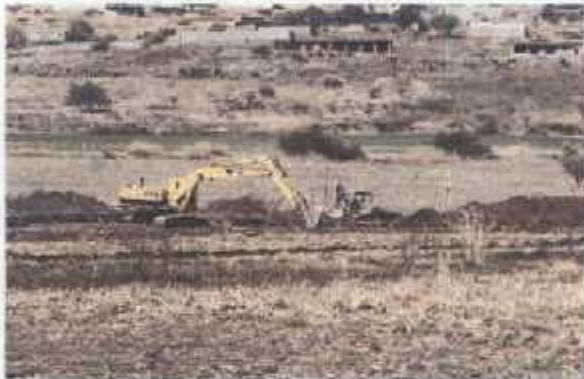
DESPALME DE OBRA
