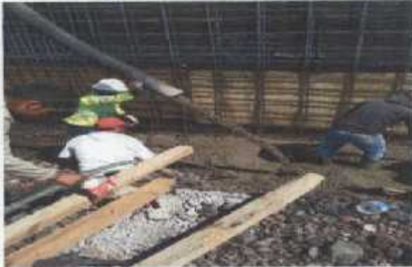
COLADO DE CONCRETO EN ZAPATAS DE M.C
