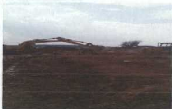
EN CORTES DE OBRA
