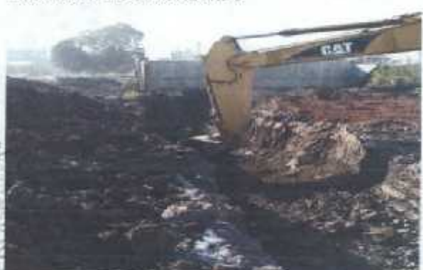
EXCAVACION DE CEPAS PARA M.C
