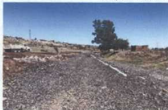
CAPA DE FILTRO EN OBRA
