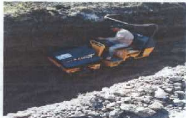
EXCAVACION DE CEPAS PARA M.C
