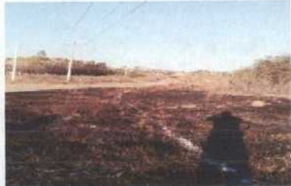
LIMPIA Y TRAZO DE OBRA
