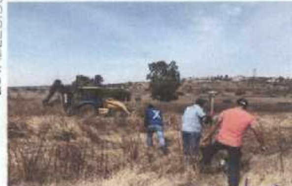
LIMPIA Y TRAZO DE OBRA
