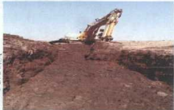
EXCAVACION DE CEPAS PARA M.C
