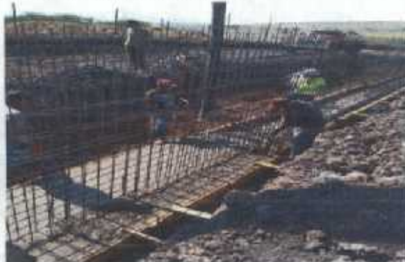
COLADO DE CONCRETO EN ZAPATAS DE M.C
