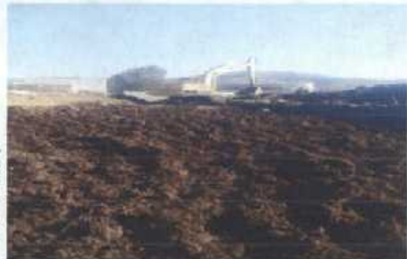
DESPALME DE OBRA
