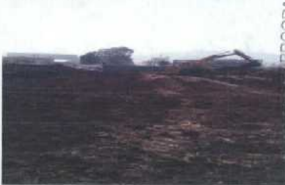
EN CORTES DE OBRA
