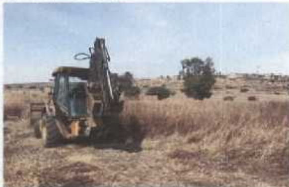
LIMPIA Y TRAZO DE OBRA
