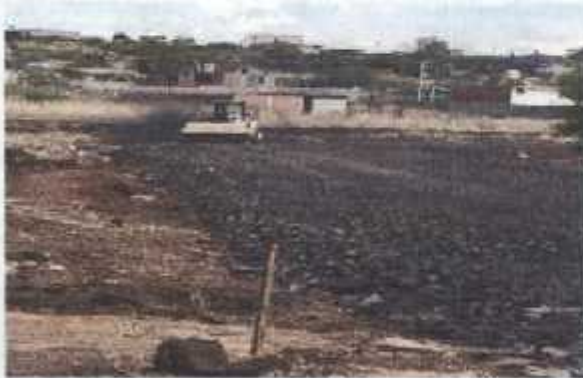
CAPA DE FILTRO EN OBRA
