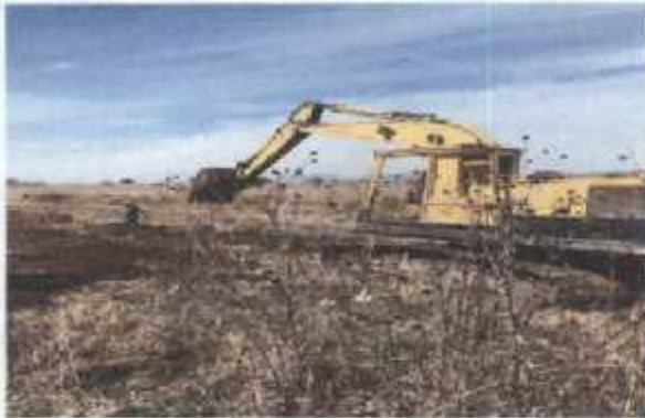
DESPALME DE OBRA
