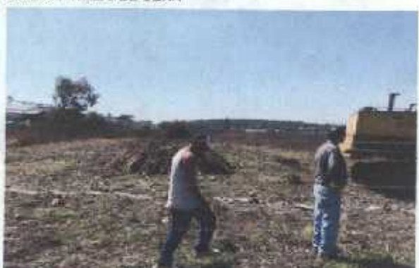
LIMPIA Y TRAZO DE OBRA
