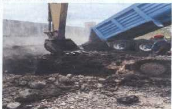
EXCAVACION DE CEPAS PARA M.C
