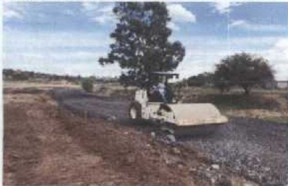
CAPA DE FILTRO EN OBRA
