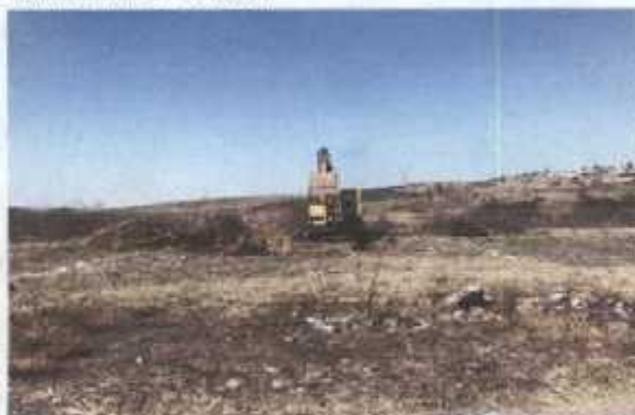
DESPALME DE OBRA
