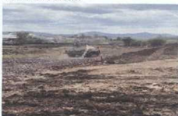
CAPA DE FILTRO EN OBRA
