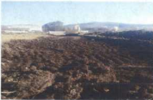
DESPALME DE OBRA
