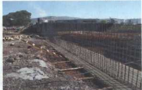
COLADO DE CONCRETO EN ZAPATAS DE M.C
