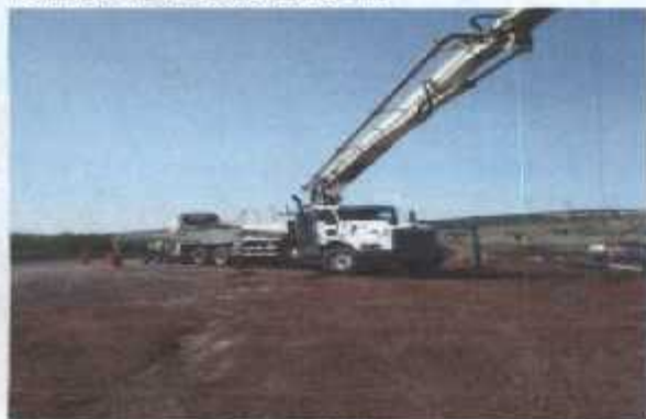
COLADO DE CONCRETO EN ZAPATAS DE M.C
