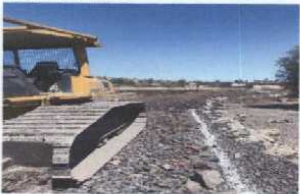
CAPA DE FILTRO EN OBRA
