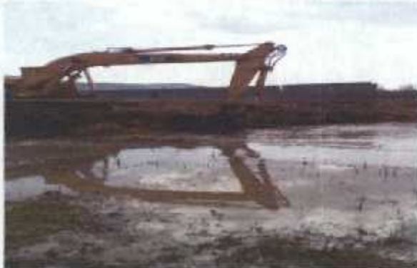
DESPALME DE OBRA
