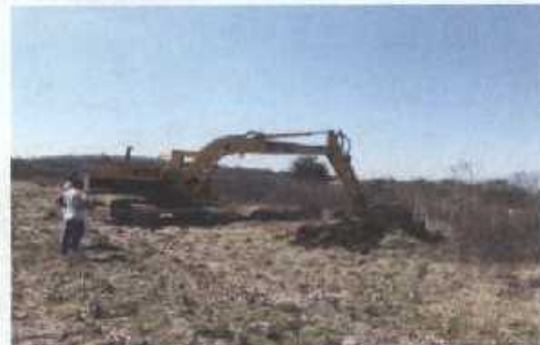
DESPALME DE OBRA
