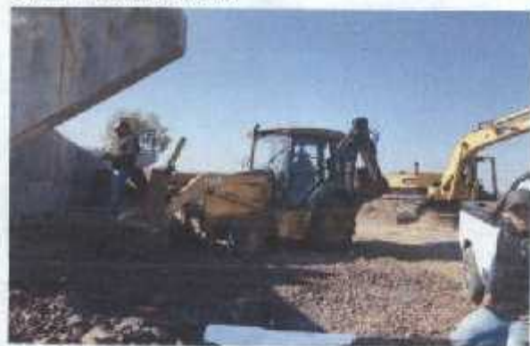
LIMPIA Y TRAZO DE OBRA
