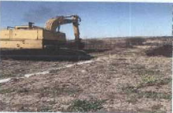
LIMPIA Y TRAZO DE OBRA
