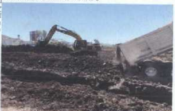
MEJORAMIENTO DE FILTRO EN CEPAS DE M.C
