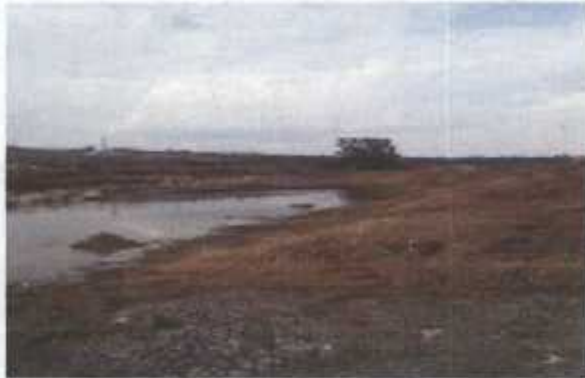
EN CORTES DE OBRA
