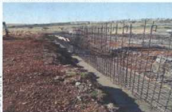
COLADO DE CONCRETO EN ZAPATAS DE M.C
