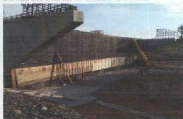
ACERO DE REFUERZO EN ZAPATAS DE M C
