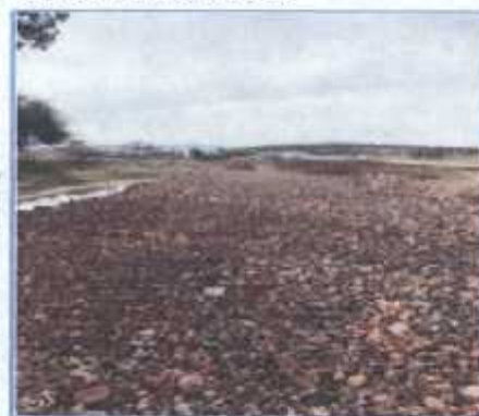
CAPA DE FILTRO EN OBRA
