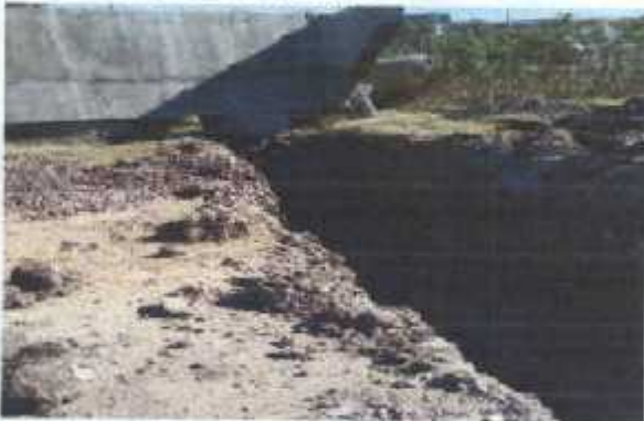
EXCAVACION DE CEPAS PARA M.C
