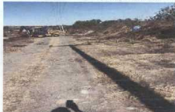
LIMPIA Y TRAZO DE OBRA
