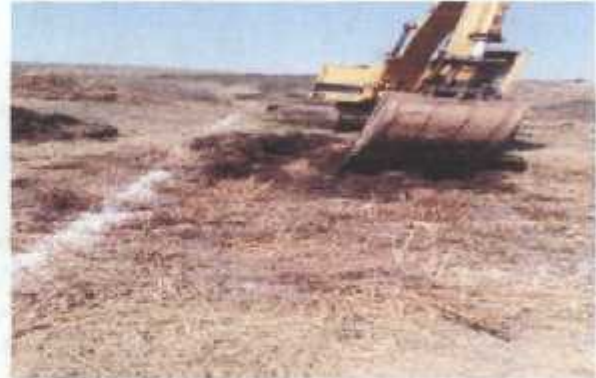
EXCAVACION DE CEPAS PARA M.C
