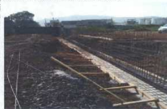
ACERO DE REFUERZO EN ZAPATAS DE M C
