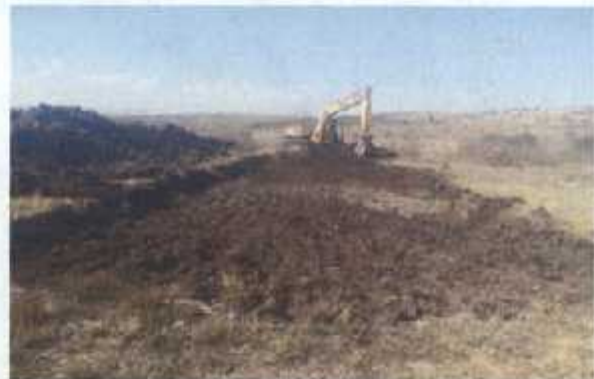
EN CORTES DE OBRA
