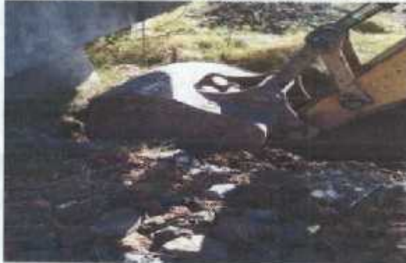
EXCAVACION DE CEPAS PARA M.C
