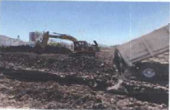
MEJORAMIENTO DE FILTRO EN CEPAS DE M.C
