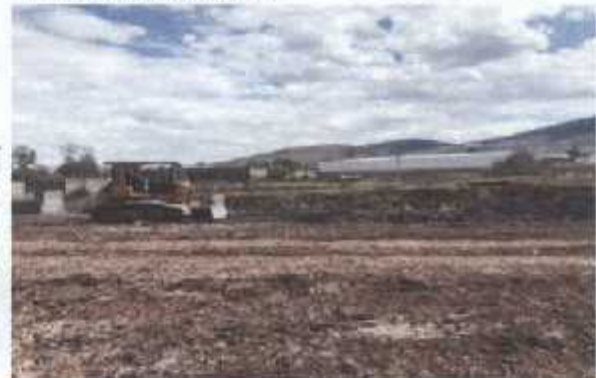
CAPA DE FILTRO EN OBRA
