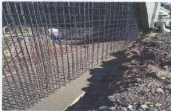
COLADO DE CONCRETO EN ZAPATAS DE M.C
