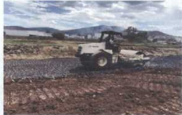
CAPA DE FILTRO EN OBRA
