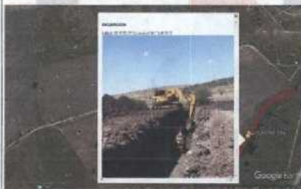
EXCAVACION Latitud: 19°43'53.76"N Longitud: 101° 8'45.93"O
