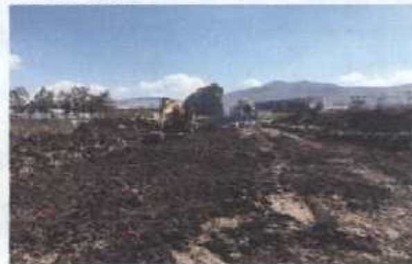
DESPALME DE OBRA
