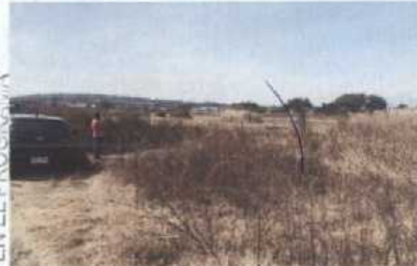
LIMPIA Y TRAZO DE OBRA
