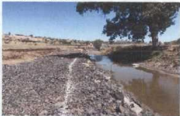
CAPA DE FILTRO EN OBRA
