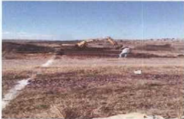
EXCAVACION DE CEPAS PARA M.C
