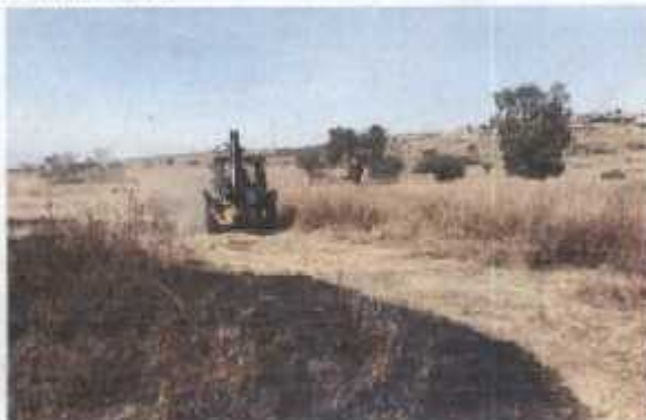
LIMPIA Y TRAZO DE OBRA
