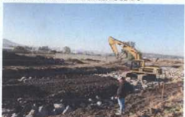
CAPA DE FILTRO EN OBRA
