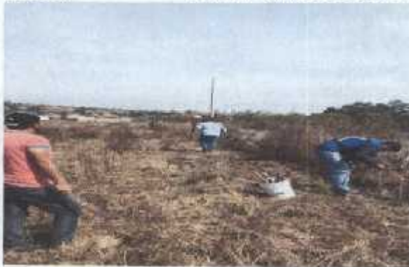
LIMPIA Y TRAZO DE OBRA
