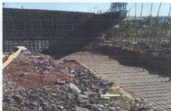
COLADO DE CONCRETO EN ZAPATAS DE M.C
