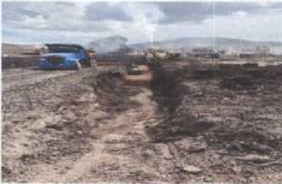
MEJORAMIENTO DE FILTRO EN CEPAS DE M C
