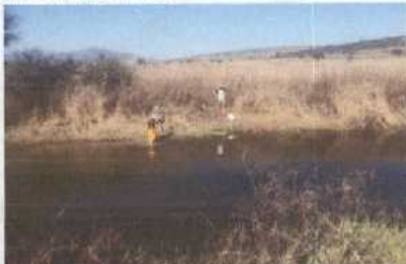
LIMPIA Y TRAZO DE OBRA
