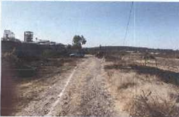
LIMPIA Y TRAZO DE OBRA
