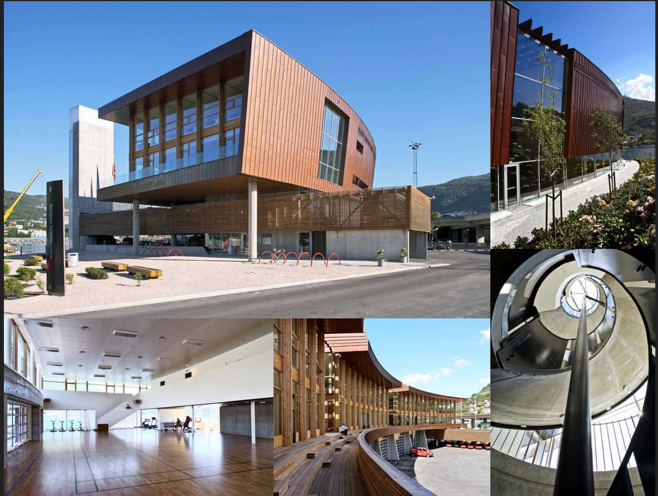
006- COLAGE DE IMÁGENES INTERIORES Y EXTERIORES DE LA ESTACIÓN DE BOMBEROS EN BERGEN, NORUEGA. FUENTE: ARCHDAILY.COM
