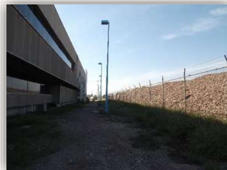
Imagen 24. Estado físico de la obra área exterior. fuelle: visita de obra sat Torreón. Consulta 11/2014.
