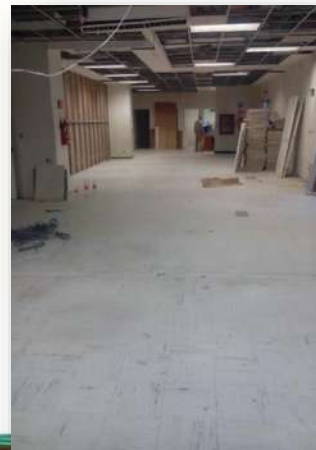
Imagen 35 Retiro piso vinílico y loseta. fuente: Angel Domínguez. Consulta: 06/2015
