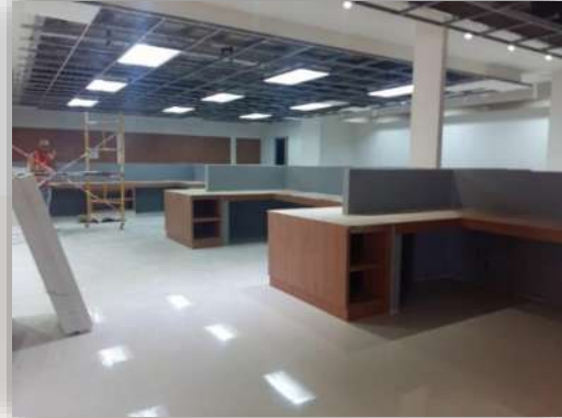
Imagen 87. Guardas bajas individuales edificio A. fuente: Angel Domínguez. Consulta: 11/2015.
