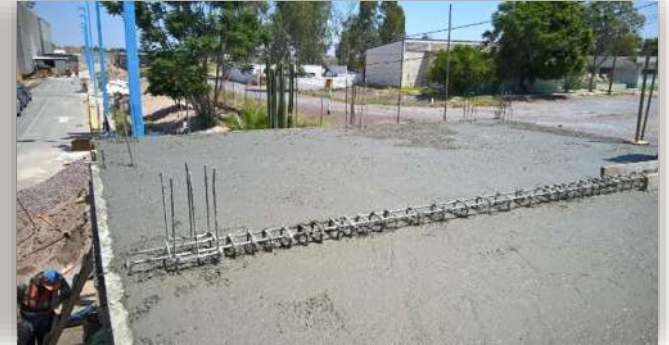
Imagen 44. Vertido de concreto en losa de comedor de empleados. Fuente: Angel Domínguez. Consulta:07/2015.
