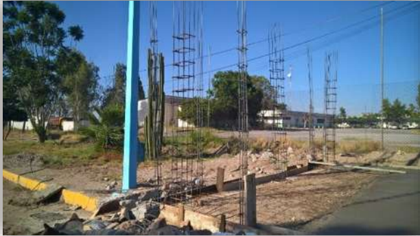
Imagen 42 Armado de castillos en comedor de empleados. fuente: Angel Domínguez. Consulta :07/2015.
