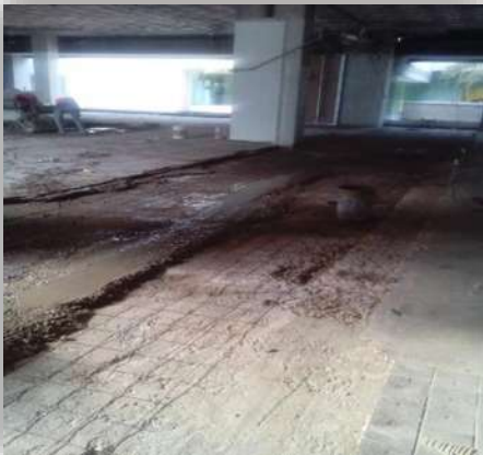
Imagen 45 y 46. Firme de re nivelación en edificio A. fuente: Angel Domínguez. Consulta 07/2015.
