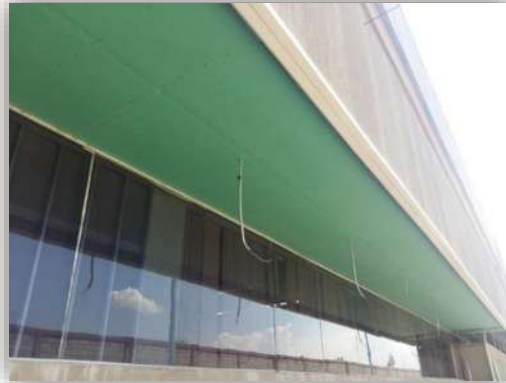
Imagen 62. Habilitado de plafón exterior edificio A. fuelle: Angel Domínguez. Consulta: 03/2016.
