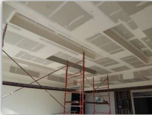
Imagen 58. Ejecución de plafón ciego edificio A. fuelle: Angel Domínguez. Consulta: 01/2016.
