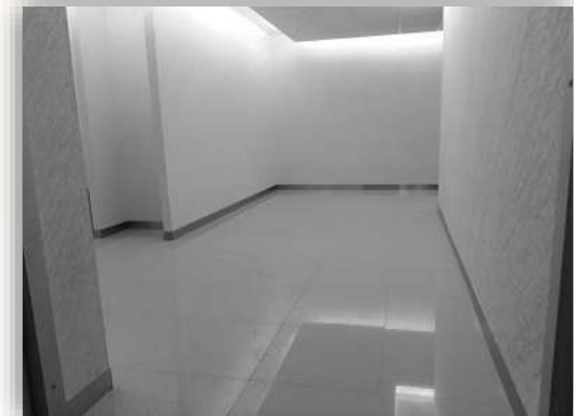
Imagen 63. Colocación de acero inoxidable edificio A. fuelle: Angel Domínguez. Consulta: 03/2016.
