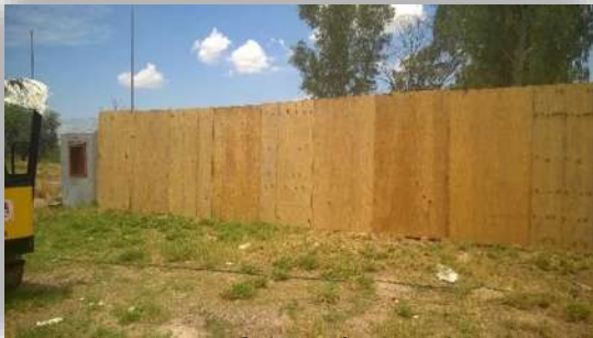
Imagen 27. Colocación de tapial en exterior. fuente: Angel Domínguez. Consulta :05/2015.
