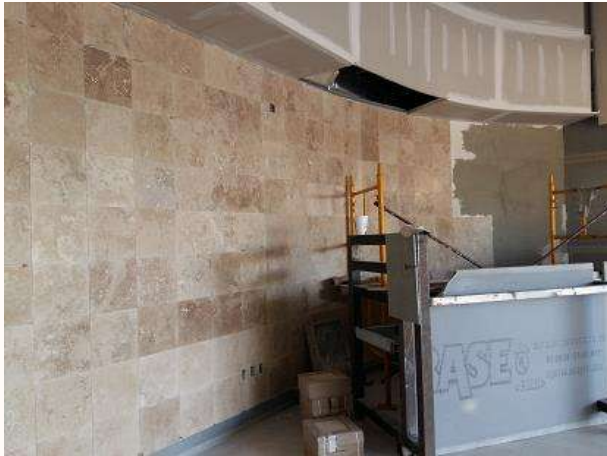
Imagen 55 Recubrimiento de mármol en muro de recepción edificio A. fuente: Angel Domínguez. Consulta: 10/2015.
