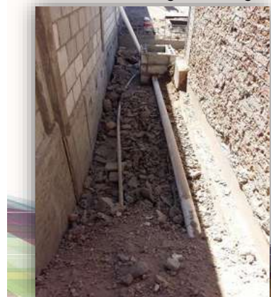
Imagen 49 Construcción de registros exteriores. fuente: Angel Domínguez. Consulta: 08/2015.
