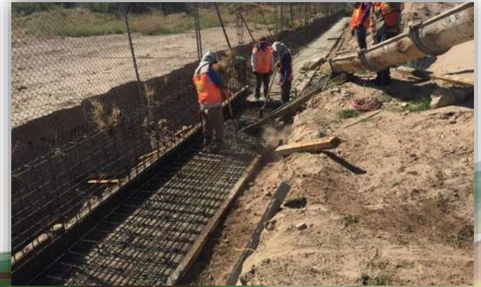
Imagen 41. Vertido de concreto en valla perimetral. fuente: Angel Domínguez. Consulta 06/2015.
