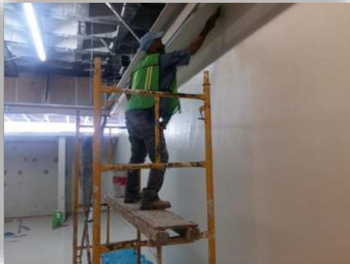
Imagen 61 Aplicación de pintura edificio A. fuelle: Angel Domínguez. Consulta: 03/2016
