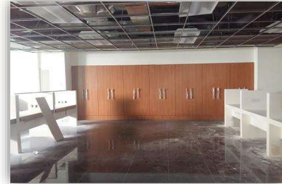
Imagen 92. Puertas y jaladeras de guardas altas edificio A. fuente: Angel Domínguez. Consulta:02/2016.
