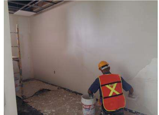
Imagen 57 Aplicación de textura en edificio A. fuente: Angel Domínguez. Consulta 10/2015.
