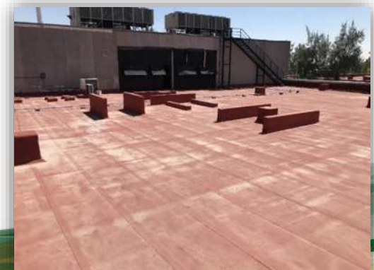
Imagen 66. Impermeabilizante de azoteas de edificios fuelle: Angel Domínguez. Consulta 07/2016.
