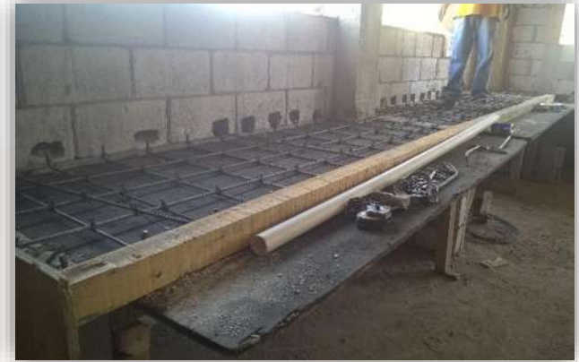
Imagen 54. Bases de concreto reforzado comedor fuente: Angel Domínguez.Consulta:08/2015.
