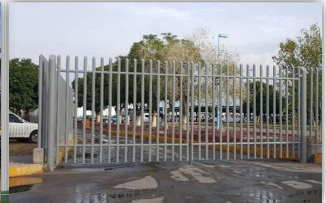
Imagen 69. Elaboración de portón de tubos para acceso de autos del personal sat: fuente: Angel Domínguez. Consulta:05/2016.
