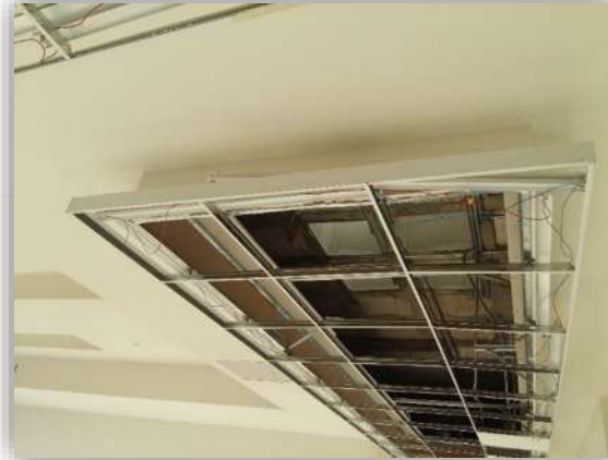
Imagen 74 Montaje de duela de aluminio en plafón reticular edificio A. fuente: Angel Domínguez. Consulta: 02/2016.
