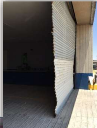
Imagen 34. Retiro de cortinas metálicas. fuente: Angel Domínguez. Consulta: 06/2015
