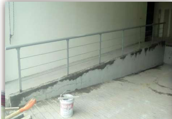
Imagen 67. Montaje de barandal en andén edificio A. fuente: Angel Domínguez. Consulta: 02/2016.
