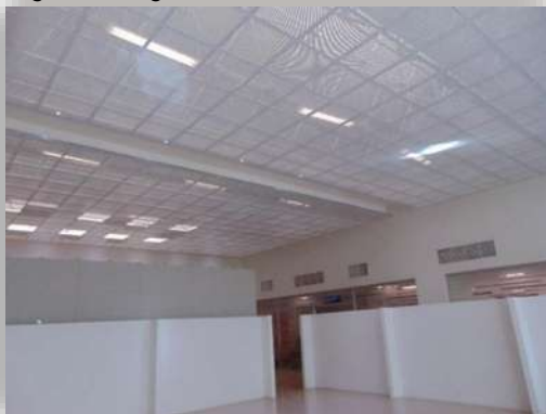
Imagen 64 Montaje de plafón perforado edificio B. fuelle: Angel Domínguez. Consulta: 06/2016.
