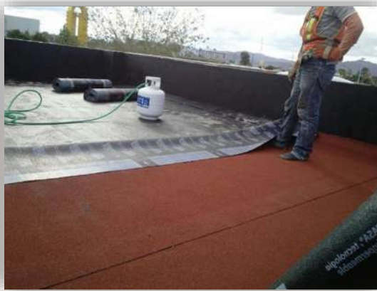
Imagen 53. Impermeabilización de azoteas de comedor. Fuente: Angel Domínguez. Consulta:08/2015.
