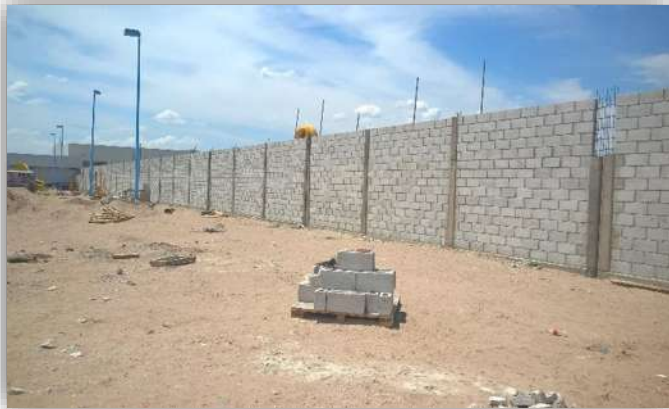
Imagen 52 Muros de mampostería en exterior. Fuente: Angel Domínguez. Consulta: 08/2015
