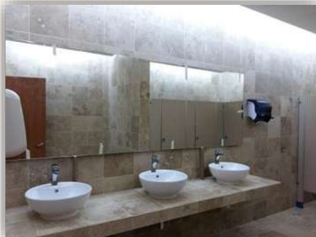
Imagen 80. Montaje de espejos en baños edificio A. fuente: Angel Domínguez. Consulta: 01/2016.
