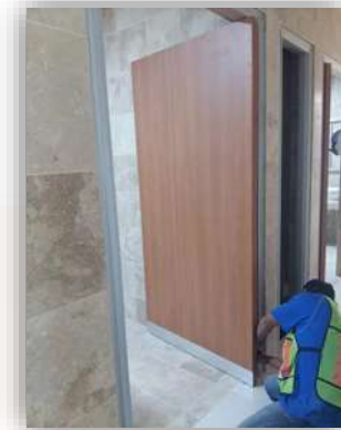
Imagen 98 y 99. Puertas de madera con antepecho en edificio C fuente: Angel Domínguez. Consulta 11/2016
