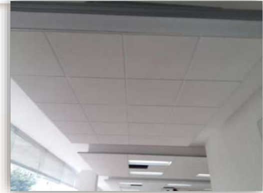
Imagen 60 Montaje de plafón modular edificio A. fuelle: Angel Domínguez. Consulta: 01/2016.
