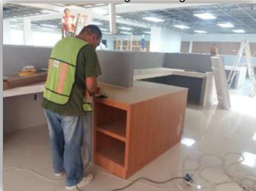
Imagen 93 Bastidor de guardas bajas individuales edificio A. fuente: Angel Domínguez. Consulta: 11/2015.
