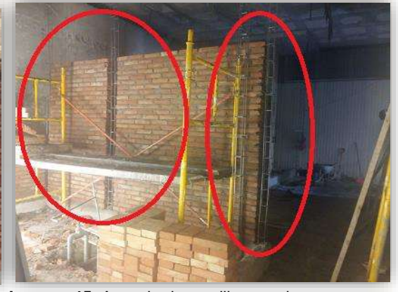
Imagen 45. Armado de castillos y traves en muros de edificio A. Fuente: Angel Domínguez. Consulta 07/2015
