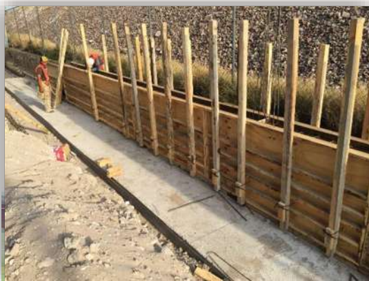
Imagen 38. Cimbra de valla perimetral en exterior. fuente: Angel Domínguez. Consulta: 06/2015.
