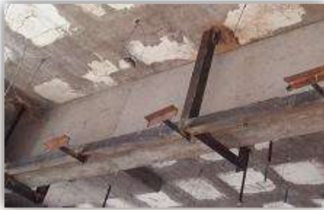
Imagen 70. Bastidor de herrería para cancel en oficialía de partes edificio A. fuelle: Angel Domínguez. Consulta 02/2016.
