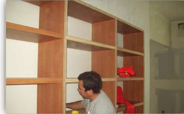
Imagen 89 Laminado en entrepaños de guardas altas en edificio A. fuente: Angel Domínguez. Consulta:01/2016
