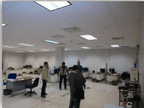
Imagen 19. Estado físico de la obra recaudación. fuelle: visita de obra sat Torreón.Consulta:11/2014.
