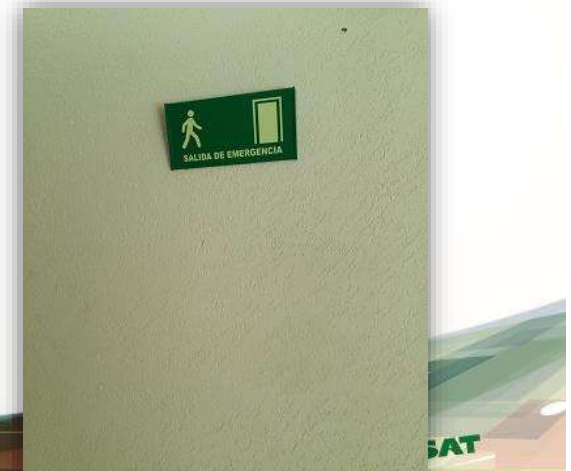
Imagen 110. Señalización de salidas de emergencia diferentes áreas. Fuente: Angel Domínguez. Consulta 10 /2016
