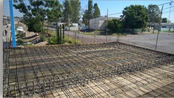
Imagen 43 Armado de losa en comedor de empleados. fuente: Angel Domínguez. Consulta: 07/2015.
