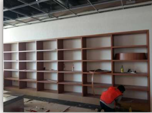
Imagen 91. Bastidor de guardas altas edificio A. fuente: Angel Domínguez. Consulta: 02/2016.
