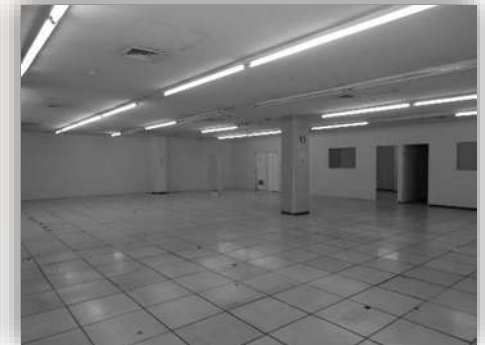
Imagen 22 Estado físico de la obra área desocupada. fuelle: visita de obra sat. Consulta Torreón 11/2014.
