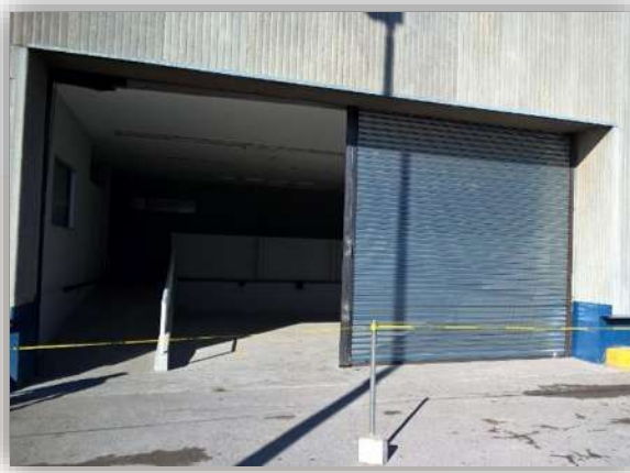
Imagen 71. Montaje de cortina perforada en andén edificio A. Fuelle: Angel Domínguez. Consulta: 02/2016.
