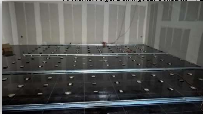
Imagen 103 Bastidor de base para archivo de alta densidad en edificio A. fuente: Angel Domínguez. Consulta: 0.1/2016
