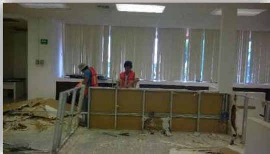
Imagen 30. Demoliciones de áreas desalojadas. fuente: Angel Domínguez. Consulta: 05/2015
