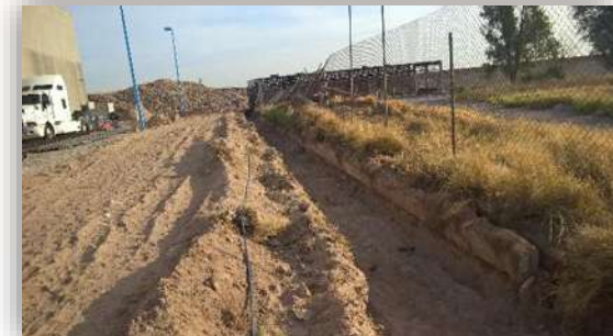
Imagen 32 Excavaciones para cimentación de valla perimetral fuente: Angel Domínguez. Consulta: 05/2015.
