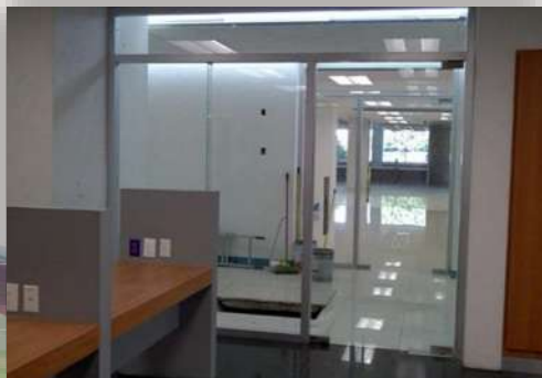
Imagen 82. Habilitado de puertas de cristal templado en pasillo de edificio A. fuente: Angel Domínguez. Consulta: 01/2016.
