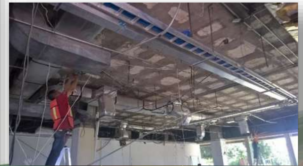
Imagen 37. Desmantelamiento de instalaciones. fuente: Angel Domínguez. Consulta: 06/2015.
