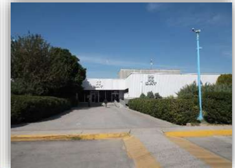
Imagen 26: Estado físico de la obra fachada de edificio A. fuelle: visita de obra sat Torreón.Consulta11/2014.
