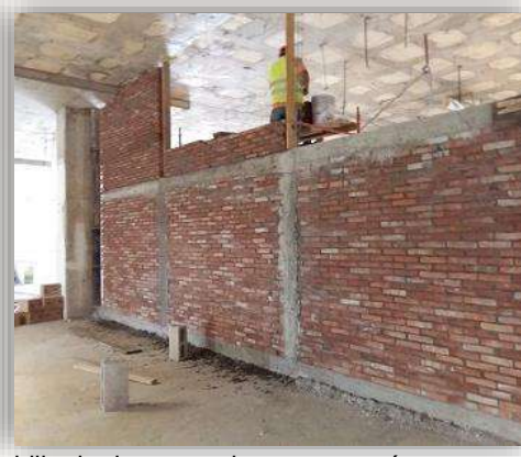
Imagen 47. Habilitado de muros de mampostería en edificio A. Fuente: Angel Domínguez. Consulta 07/2015.
