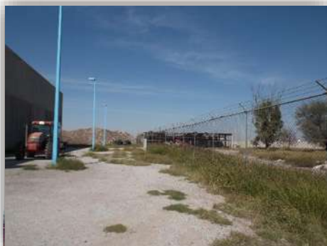
Imagen 23 Estado físico de la obra área exterior. fuelle: visita de obra sat Torreón. Consulta: 11/2014
