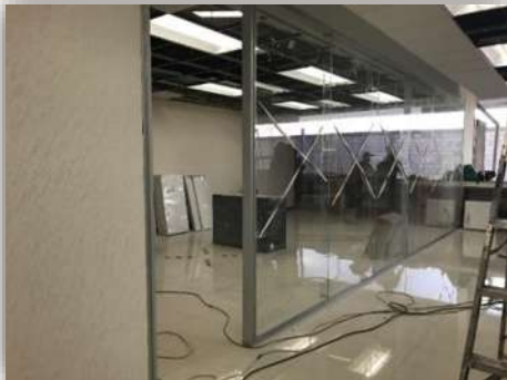
Imagen 79. Colocación de cristales templados en cancelas en oficinas. Fuente: Angel Domínguez. Consulta: 02/2016.
