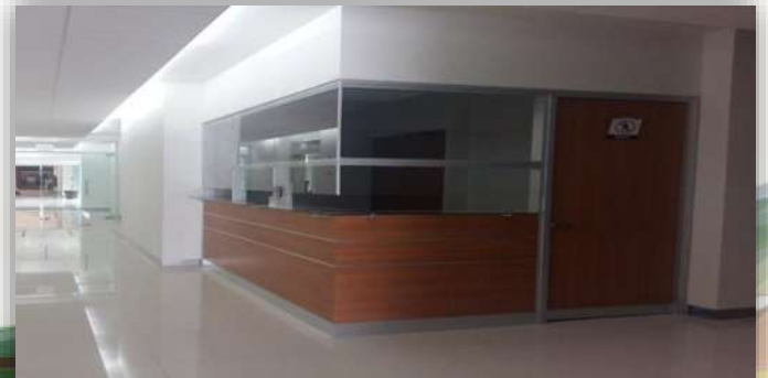
Imagen 84. Habilitado de cristal templado en caseta de vigilancia edificio A. Fuente: Angel Domínguez. Consulta: 01/2016
