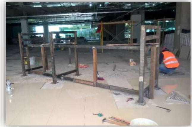
Imagen 72 Habilitado de bastidor para mueble de recepción edificio A. Fuelle: Angel Domínguez. Consulta 02/2016.
