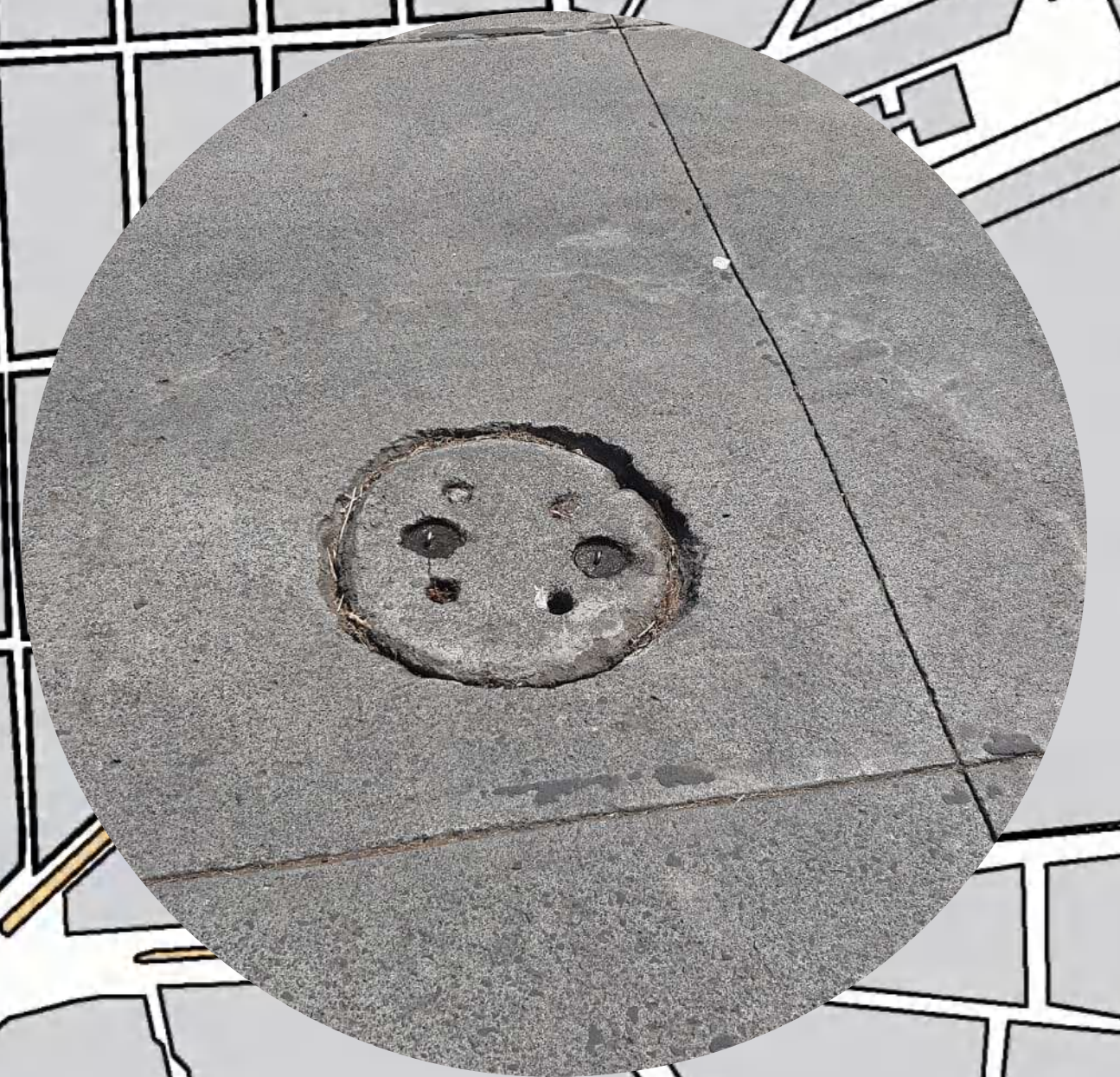
6. COLADERAS DETERIORADAS
