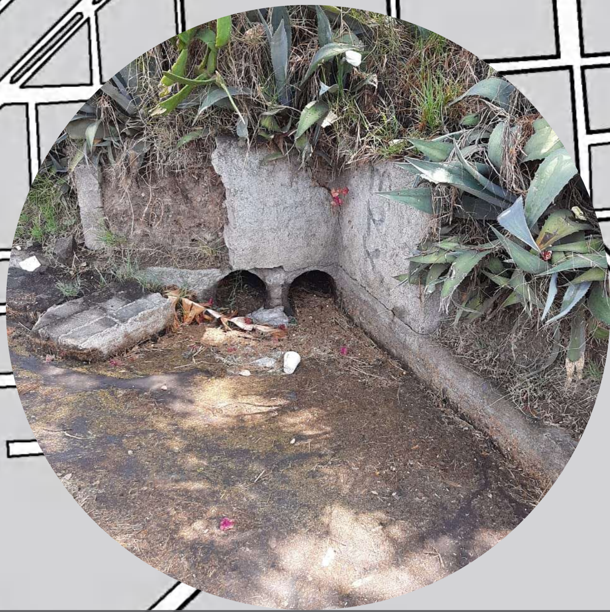
3. TUBERIA DETERIORADAS
