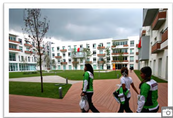
Figura 75: Edificio Habitacional, iluminación y ventilación, autor: Cortesía, fuente: Villa panamericana Guadalajara 2017
