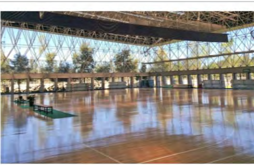
Foto 27: Interior del Pabellón de Gimnasia CNAR, Autor: Cortesía CNAR, Fecha de captura: enero 2019.
