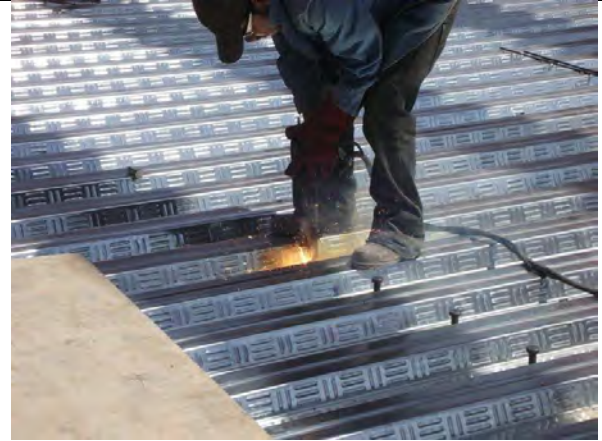
Imagen no. 73.- Colocación de pernos de cortante entre lámina y estructura.
