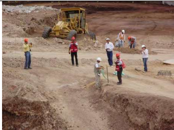
Imagen no. 58.- Trazo de ejes, referencias y nivelación.
