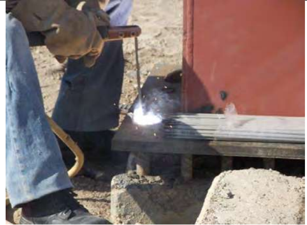
Imagen no. 67.- Soldado de columna metálica a placa base.
