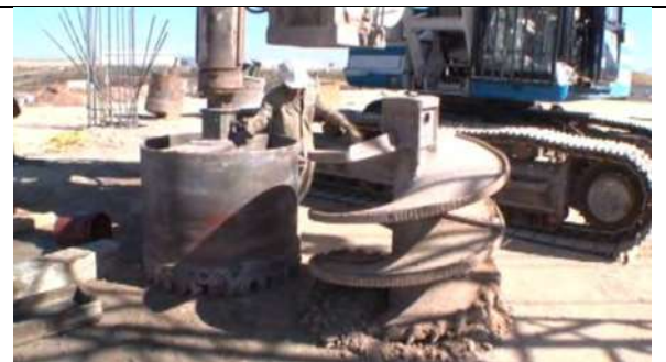
Imagen no. 36.- Perforación para pilotes.
