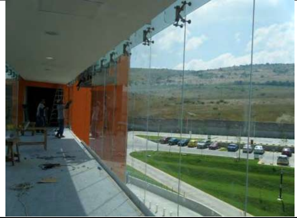
Fuente: Archivo residencia de obra.
