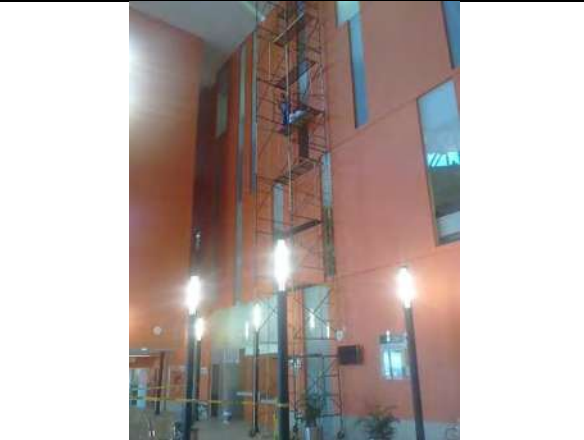
Fuente: Archivo residencia de obra.
