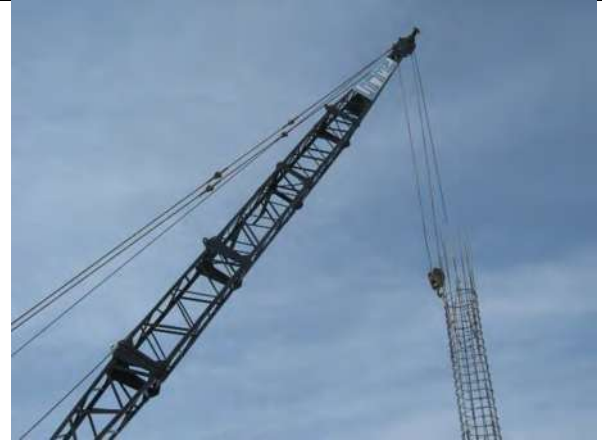
Fuente: Archivo residencia de obra.
