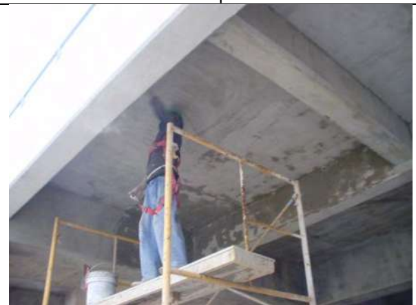
Imagen no. 85.- Detallado y resanado de losa de concreto aparente.
