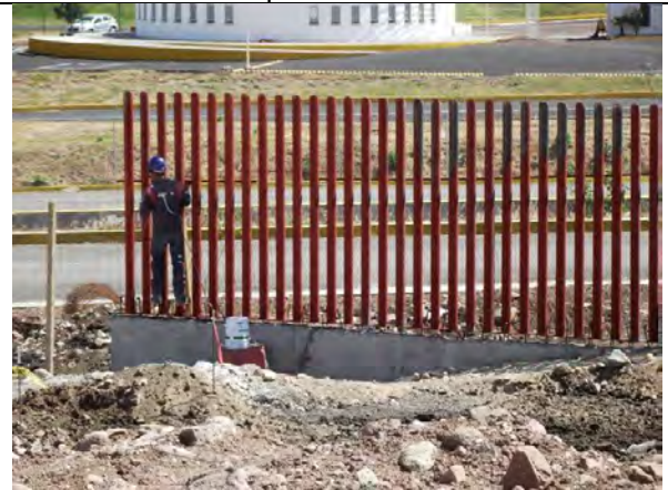
Imagen no. 59.- Construcción de muro perimetral.
