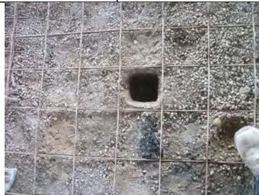
Imagen no. 79.- Cala para prueba de compactación.
