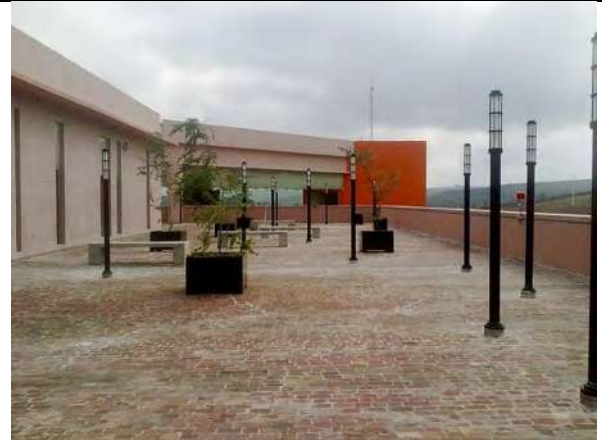
Fuente: Archivo residencia de obra.
