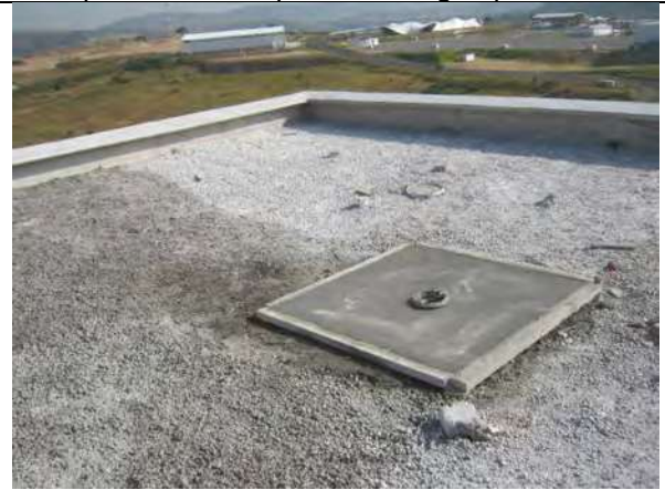
Imagen no. 87.- Relleno en azotea para dar pendiente a captación de agua pluvial.
