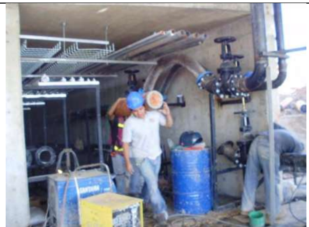
Imagen no. 103.- Instalaciones hidráulicas y eléctricas.
