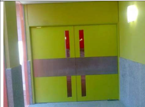
Imagen no. 104.- Puerta de madera acabado con melamina, con mirilla y protección contra camillas.
