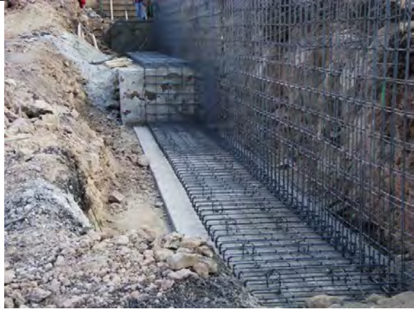
Imagen no. 140.- Cimentación para recibir barda perimetral.
