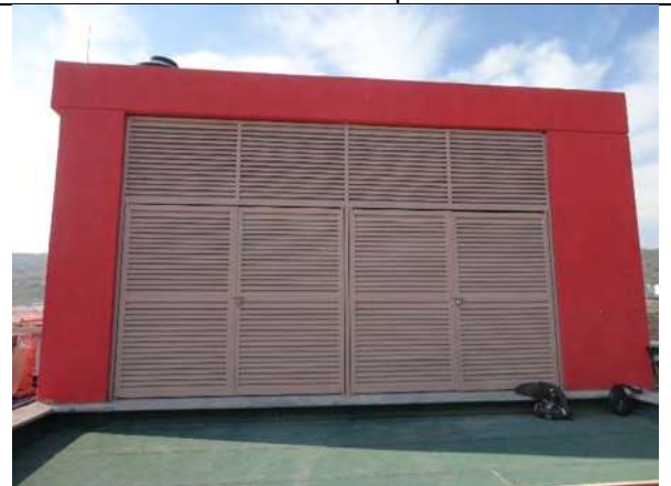
Imagen no. 107.- Puertas de herrería tipo louver en casa de máquinas.
