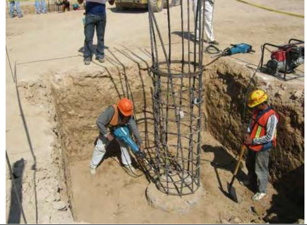
Fuente: Archivo residencia de obra.
