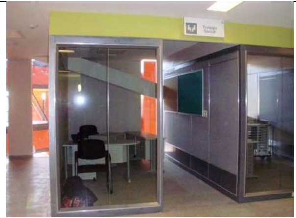
Imagen no. 123.- Muros prefabricados en área de oficinas.
