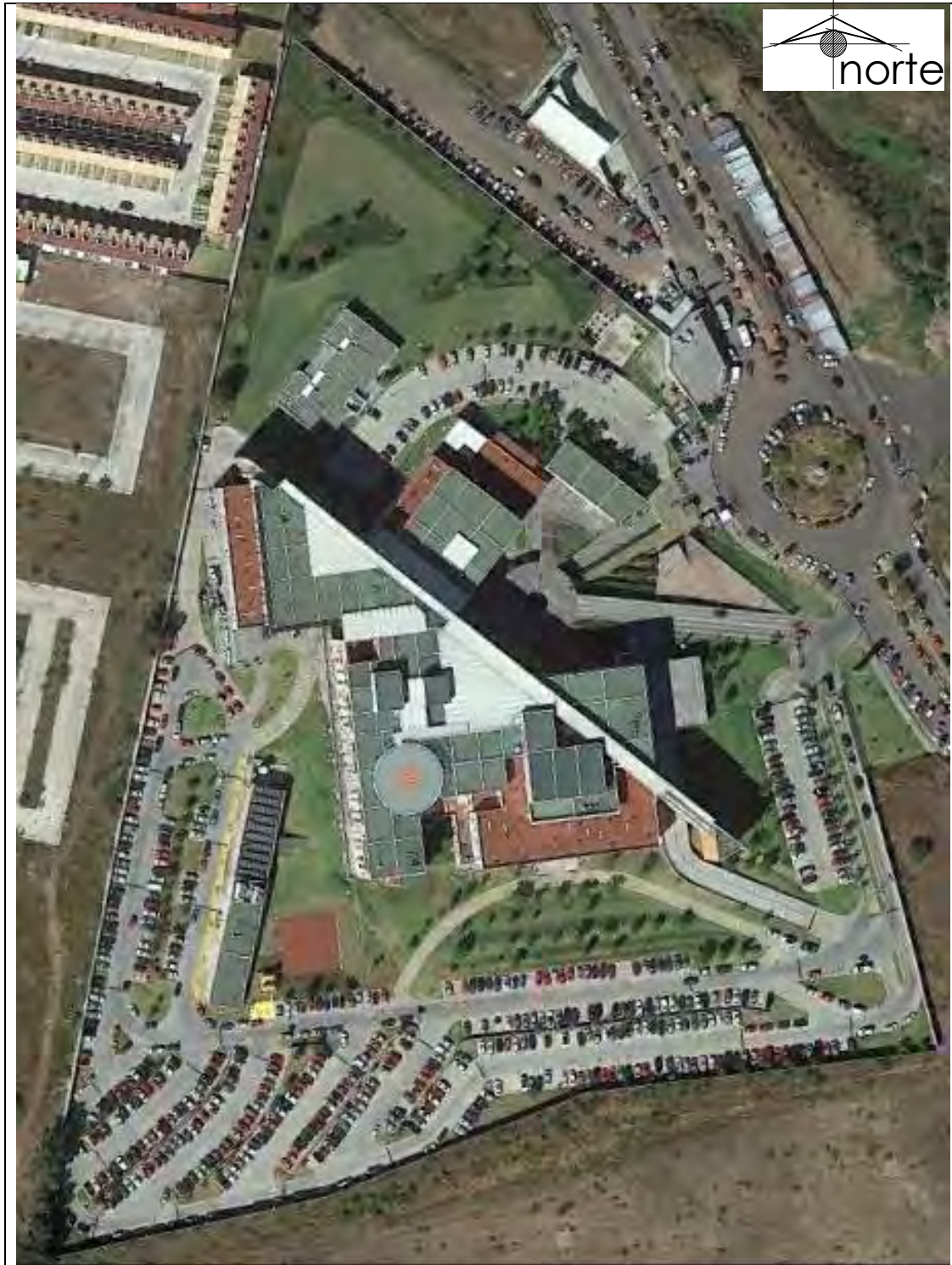
Imagen no. 11.- Vista aérea del HGR 250 camas, en Charo, Mich.
