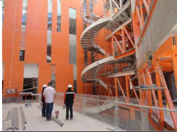
Fuente: Archivo residencia de obra.
