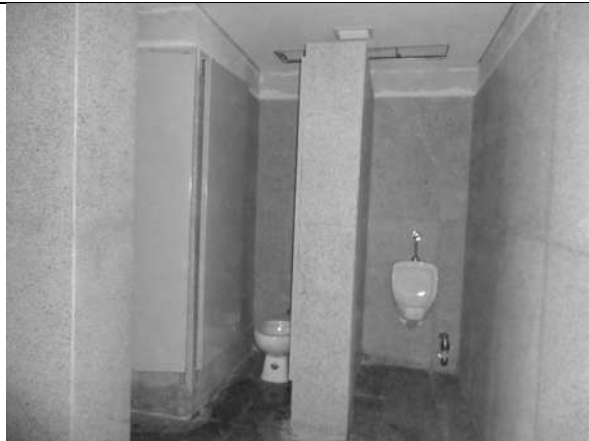
Imagen no. 116.- Granito de mármol en muros de baños.
