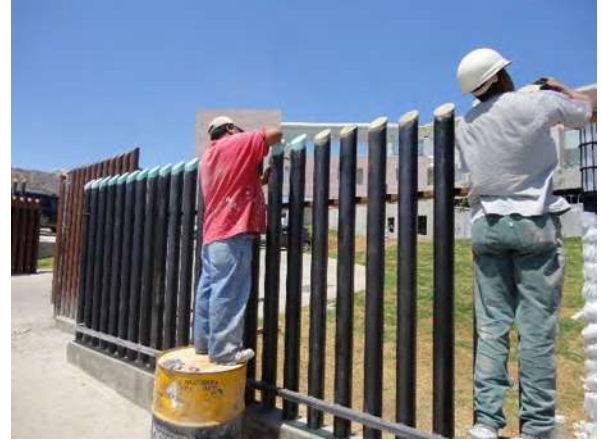
Imagen no. 149.- Preparación de herrería perimetral para recibir pintura.
