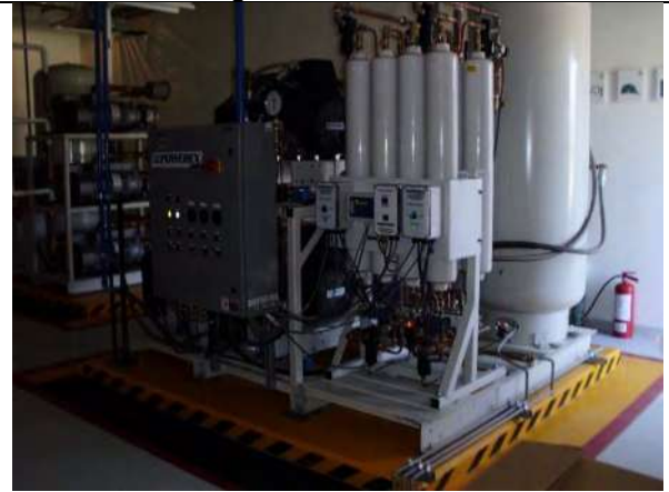
Imagen no. 99.- Casa de máquinas de equipos de gases medicinales.
