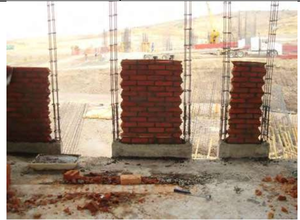
Imagen no. 81.- Levantamiento de muros de tabique en fachada.
