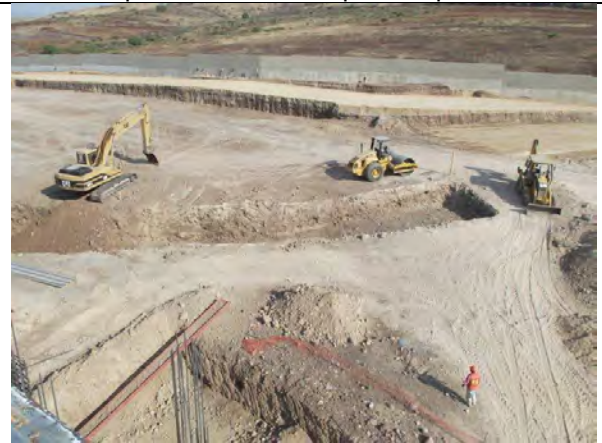
Imagen no. 143.- Excavación, nivelación y compactación con maquinaria pesada.
