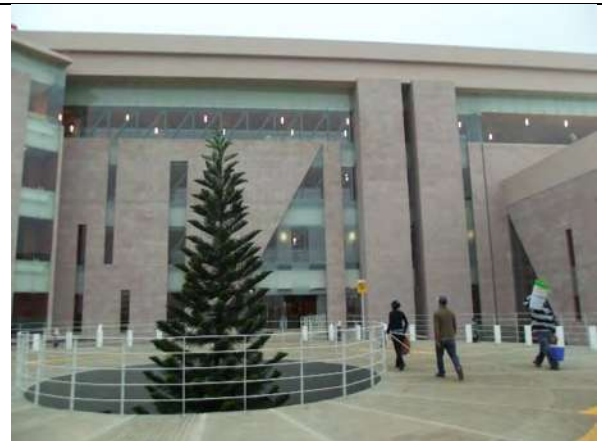
Imagen no. 151.- Motor lobby.
