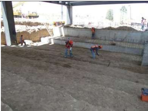
Imagen no. 78.- Formación de escalones en área de auditorio.
