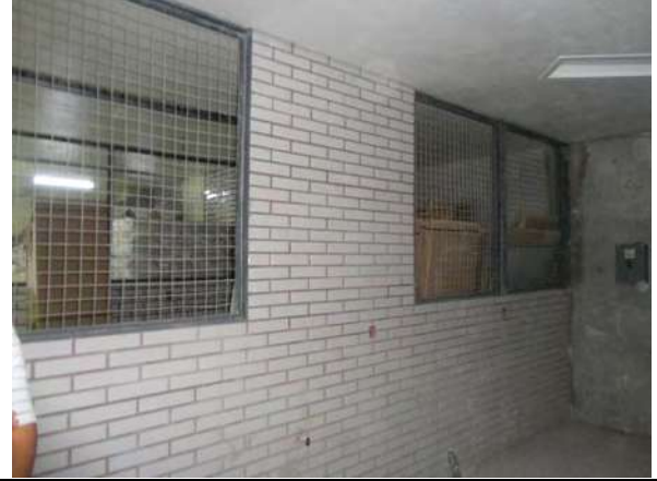
Imagen no. 115.- Muros de tabique esmaltado en área de conservación.
