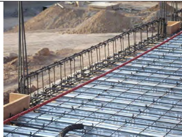
Imagen no. 74.- Colocación de malla electrosoldada en losacero.
