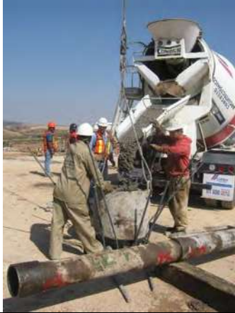
Fuente: Archivo residencia de obra.
