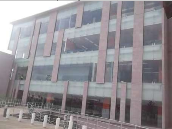
Imagen no. 110.- Fachada a base de cristal templado y cantera rosa.
