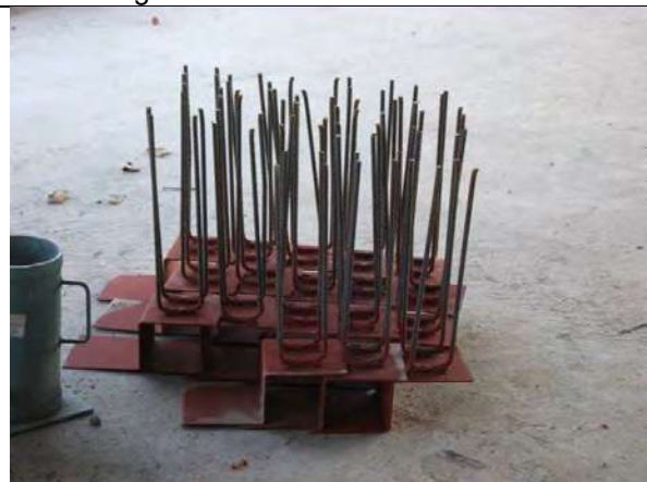
Imagen no. 84.- Zeta de lámina de acero para rigidización de muros interiores.
