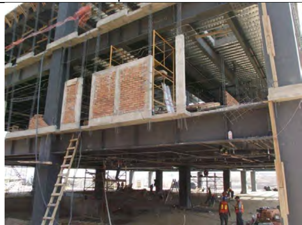
Imagen no. 82.- Levantamiento de muros de tabique en fachada.
