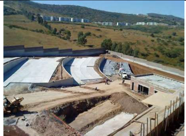
Imagen no. 145.- Concreto hidráulico en plataformas para estacionamiento.
