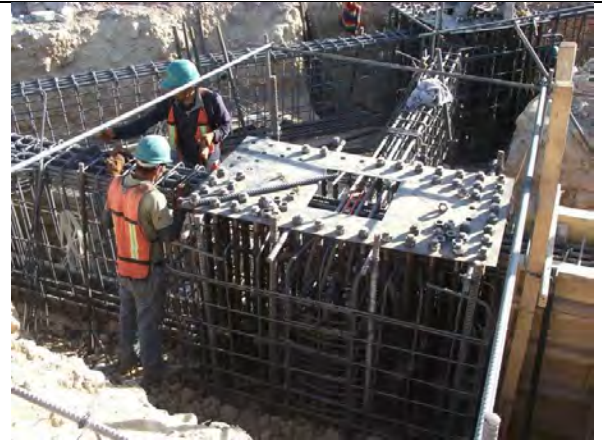
Fuente: Archivo residencia de obra.
