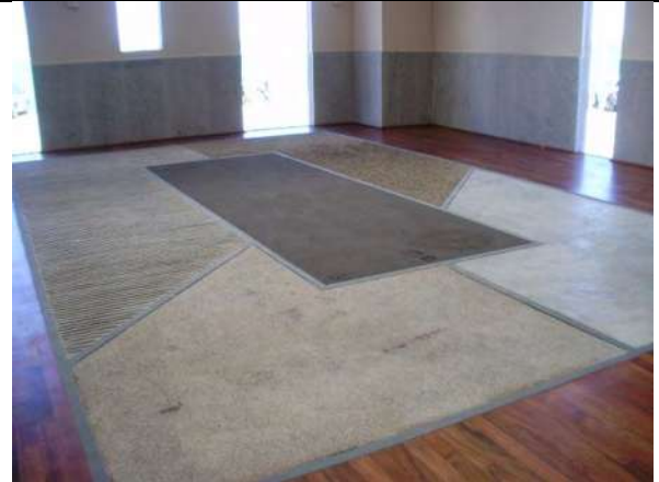
Imagen no. 119.- Acabado en piso en área de marcha de medicina física.
