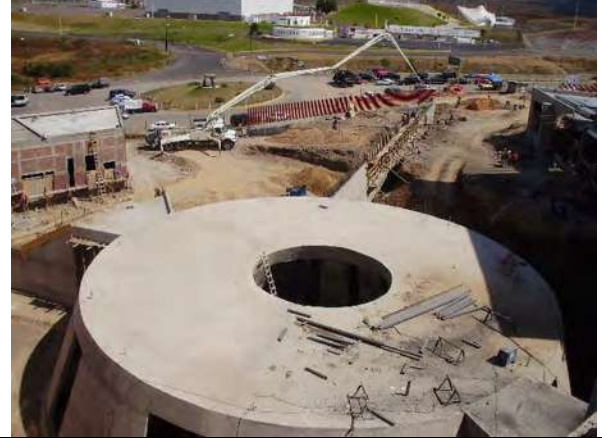
Imagen no. 147.- Colado de motor lobby.
