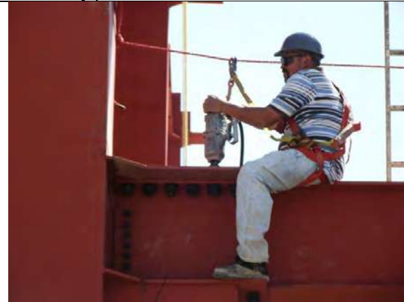
Imagen no. 70.- Apretado de tuercas entre vigas y placas soldadas a columnas.
