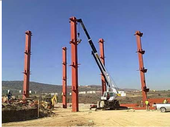
Imagen no. 66.- Izamiento de columnas mediante grúa.
