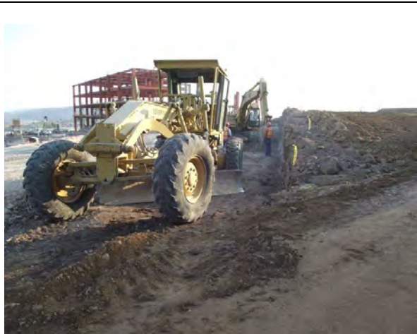
Imagen no. 142.- Nivelación y extendido de material inerte.
