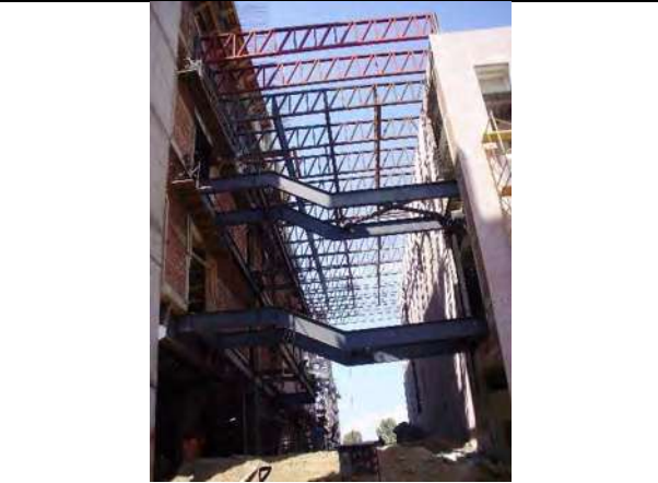
Imagen no. 77.- Estructura metálica en puentes y domos de interconexión entre edificios.
