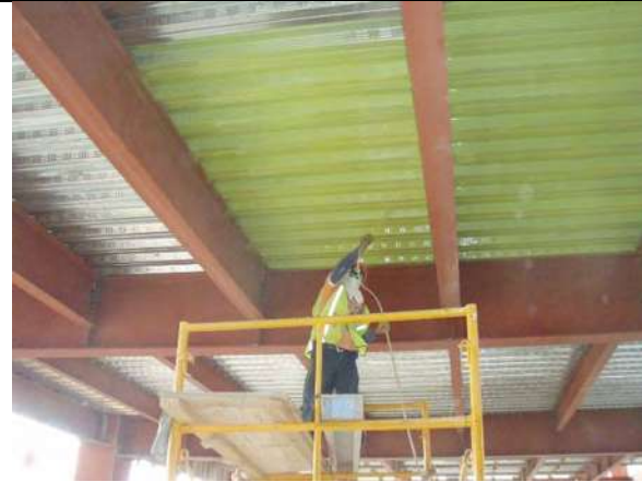
Imagen no. 76.- Aplicación de primario en losacero para recibir pintura intumescente.
