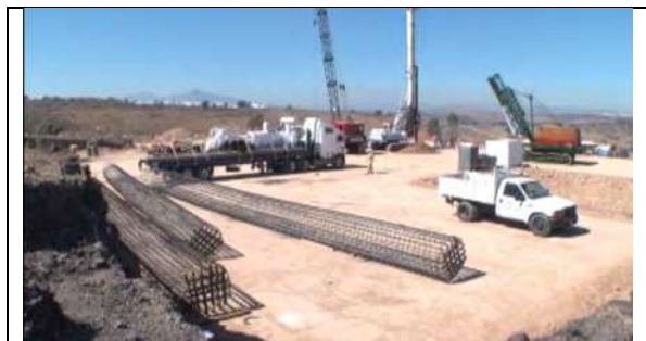
Imagen no. 37.- Armado de jaulas.
