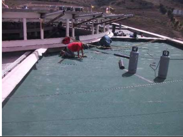
Imagen no. 114.- Impermeabilización en azoteas con material en rollo prefabricado.
