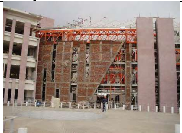
Imagen no. 91.- Fachada de albañilerías.
