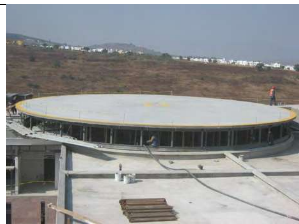
Imagen no. 118.- Helipuerto.
