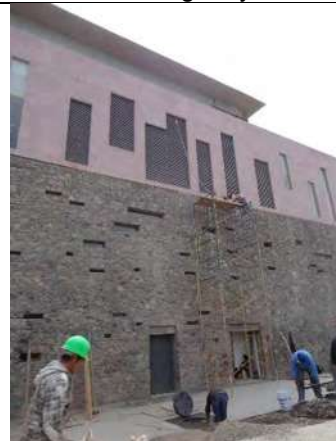
Imagen no. 111.- Acabado en fachadas de piedra braza de la región y cantera rosa.
