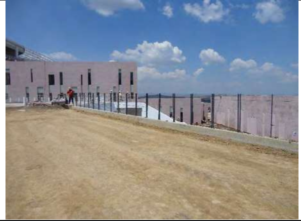
Imagen no. 129.- Nivelación de área exterior para recibir pasto.
