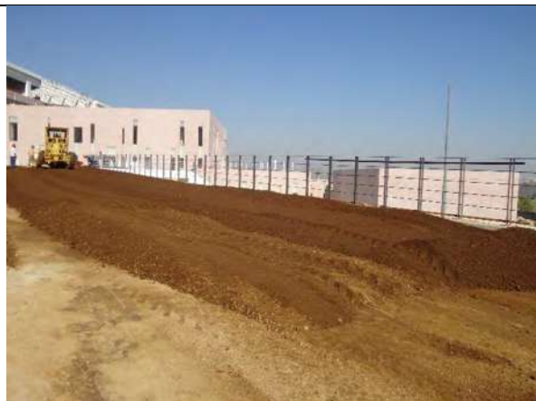
Imagen no. 126.- Extendido de tierra lama.
