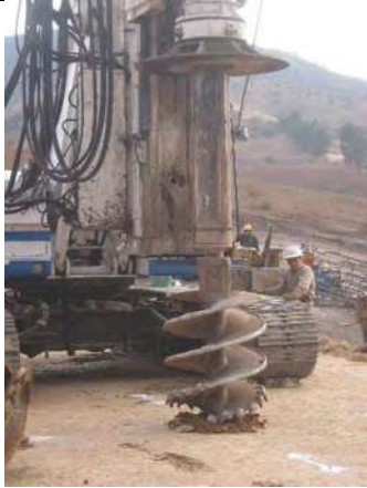
Fuente: Archivo residencia de obra.
