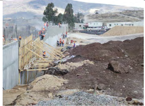
Imagen no. 141.- Barda perimetral con block cara de piedra.
