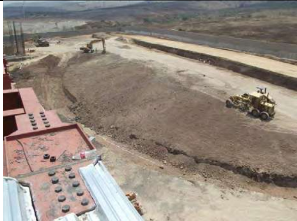
Imagen no. 144.- Nivelación en superficie de rodamiento.
