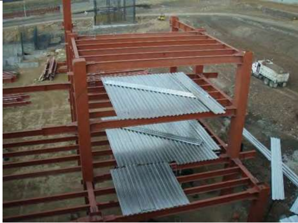
Imagen no. 72.- Colocación de láminas galvanizadas en entrepisos.
