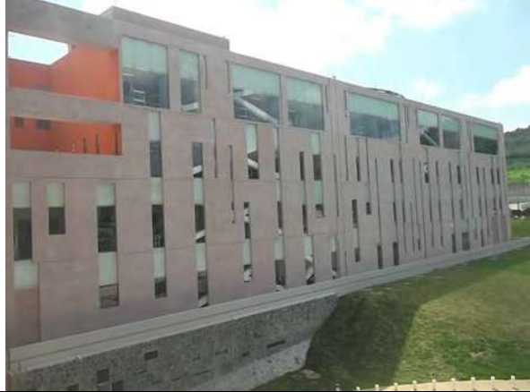
Imagen no. 120.- Fachada de hospitalización.
