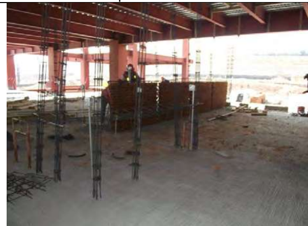
Imagen no. 83.- Levantamiento de muros de tabique en interiores.
