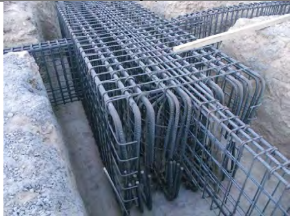
Fuente: Archivo residencia de obra.
