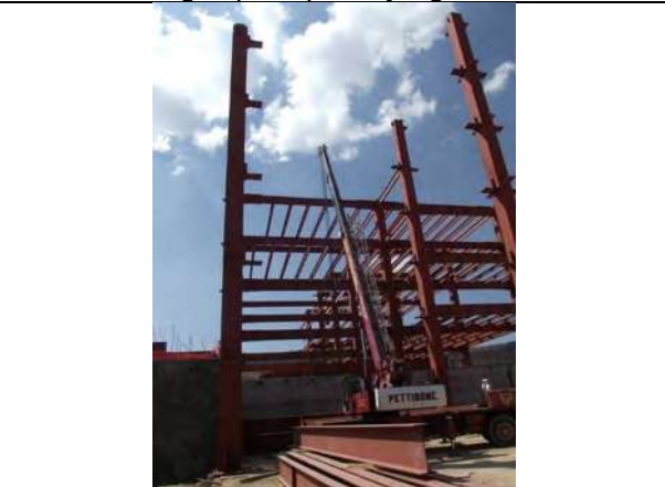
Imagen no. 71.- Estructura metálica a base de columnas, vigas principales y vigas secundarias.
