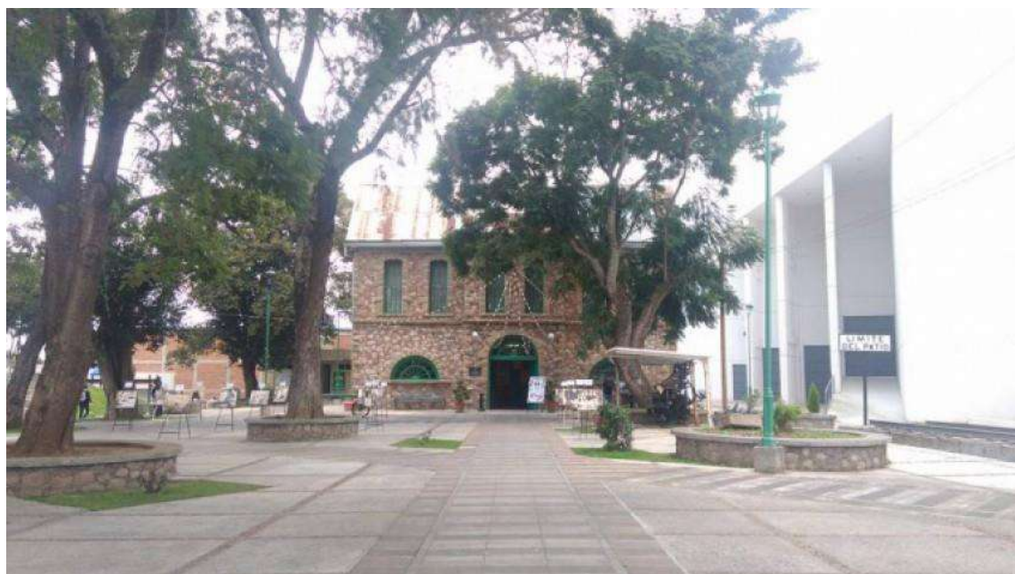
Imagen 13.- Fotografía de la casona de la estación (museo de la estación) a un costado (izquierda) se observa el teatro Juárez
